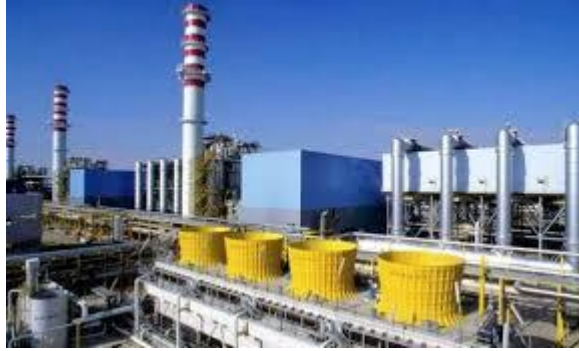
Figure I.2 : Centrale électrique de Bellera
