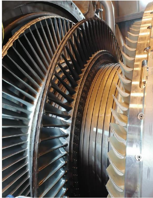
Figure II.7 : Ailettes de la turbine MS 9001FA remontées (avant l'amélioration) [3]
