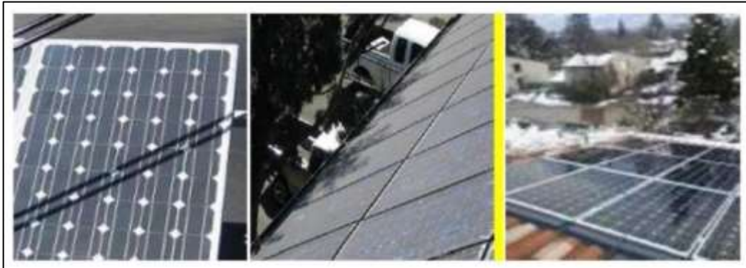
Figure 1.9. Défaut d'ombrage partiel [10]
