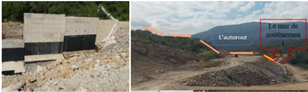
Fig.IV.1. Réalisation des murs au niveau du PK 21+020.
