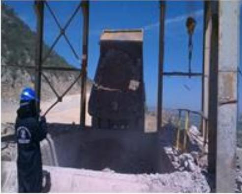
*Fig.V.17-Déchargement du camion au niveau du concasseur primaire)(Bichara, Belfihadj)*
