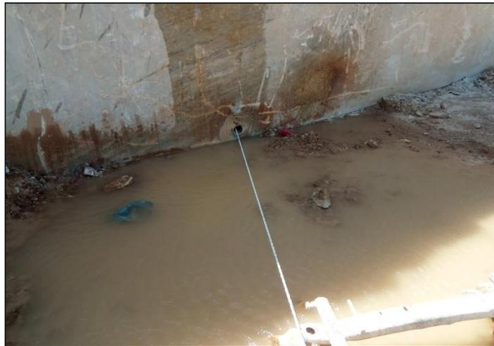
*Fig.V.5- Le Fil diamanté sortant des trous de foration.*
