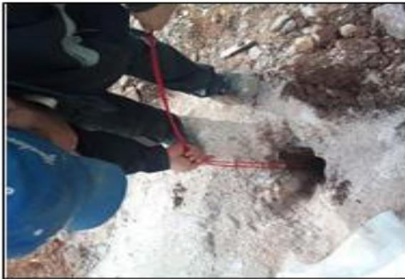
Fig.V.13-Chargement de la marmanit dans le trou. (Bichara, Belfihadj)
