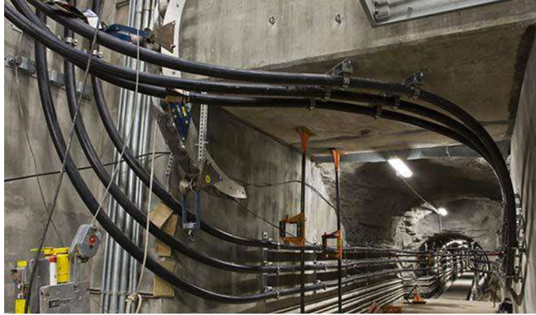
Figure I.2. Lignes électriques souterraines.
