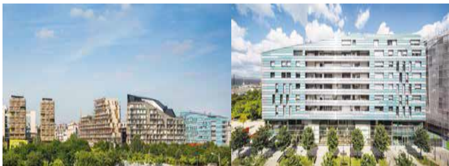
fig. n° [20] Bâtiment peu énergivore. Source : éco-quartier ; une référence de développement urbain durable à Paris.
