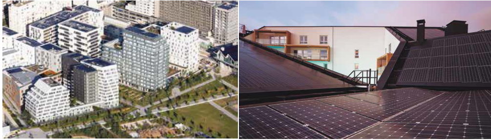
fig. n° [21] Vue aérienne sur les toitures photovoltaïques les toitures photovoltaïques
