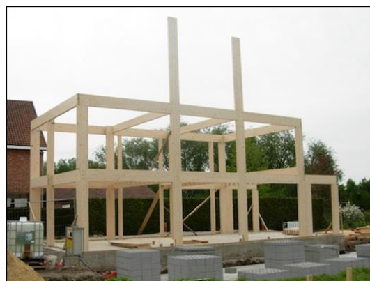
Figure26 : Système poteaux-poutres Source : livios.2017
