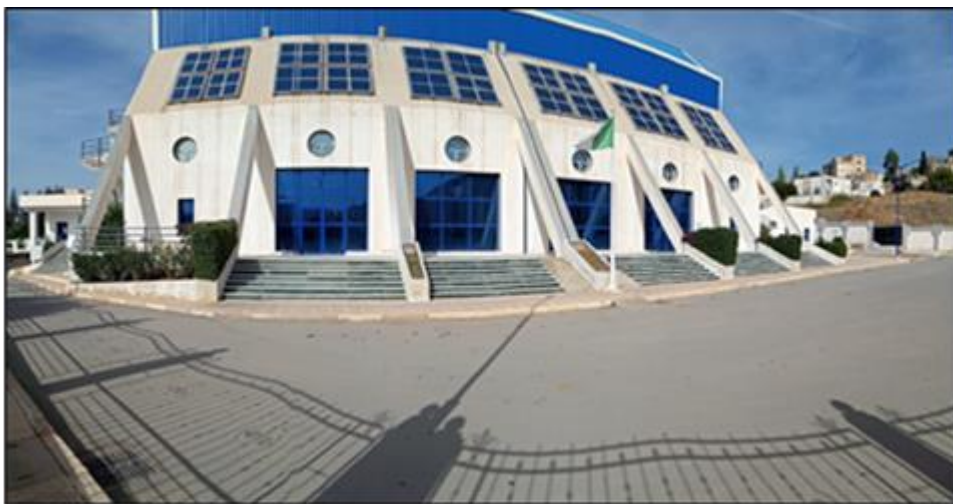
Figure 69 : façade sud piscine semi olympique de Ferdjioua Prise le 25/11/2022
