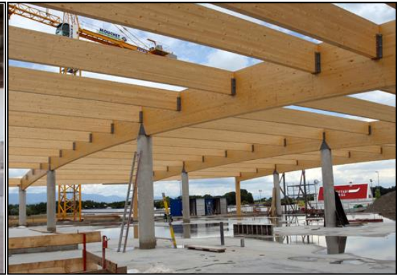
Figure52 : matériaux utilisés dans la piscine Source : Albahja Marrakech ,2023
