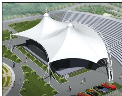
Figure30 : structure tendue. Source : judy fu.2019
