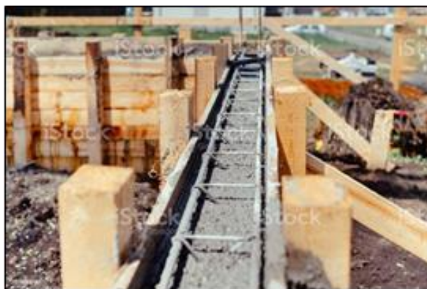
Figure23 : béton armée Source : Bogdanhoda.2019
