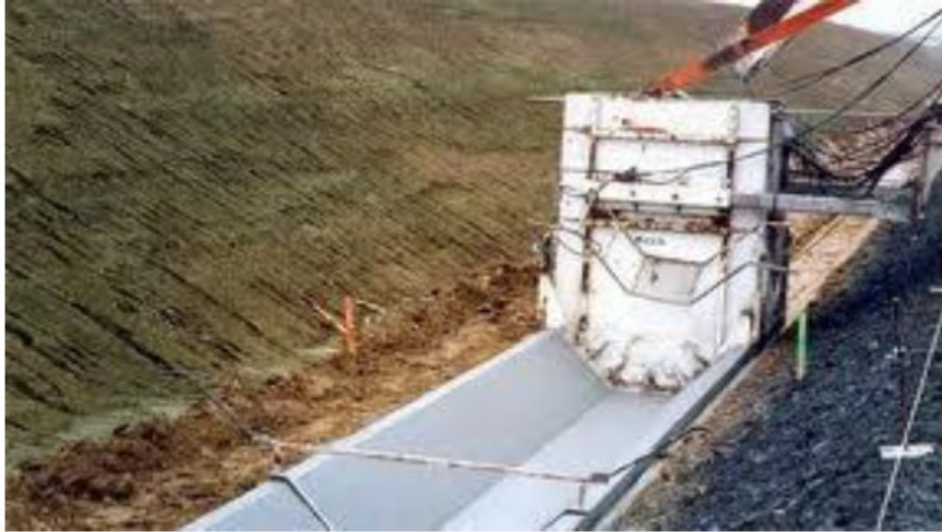
Figure .V.6. Photo de drainage de surface.
