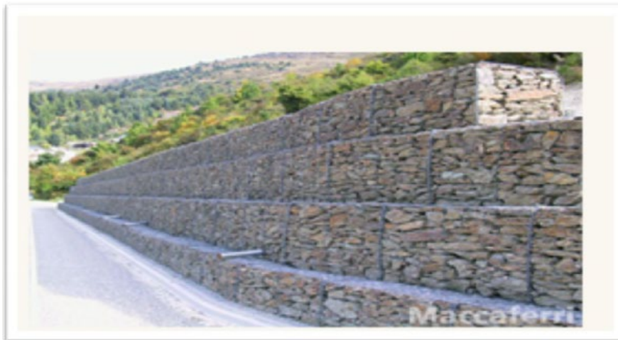
Figure .V.9. Modèle de soutènement par Gabions
