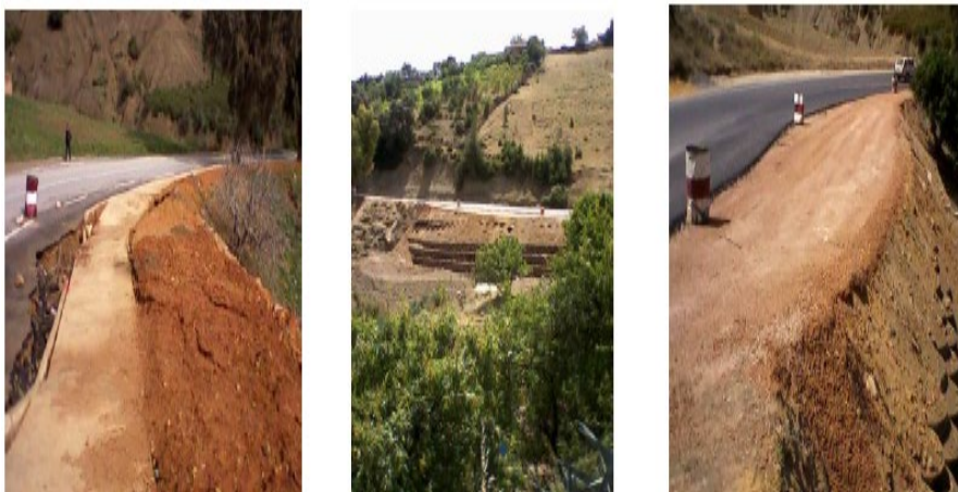
Figure .V.16. Exemple d'ouvrage en Pneu sol
