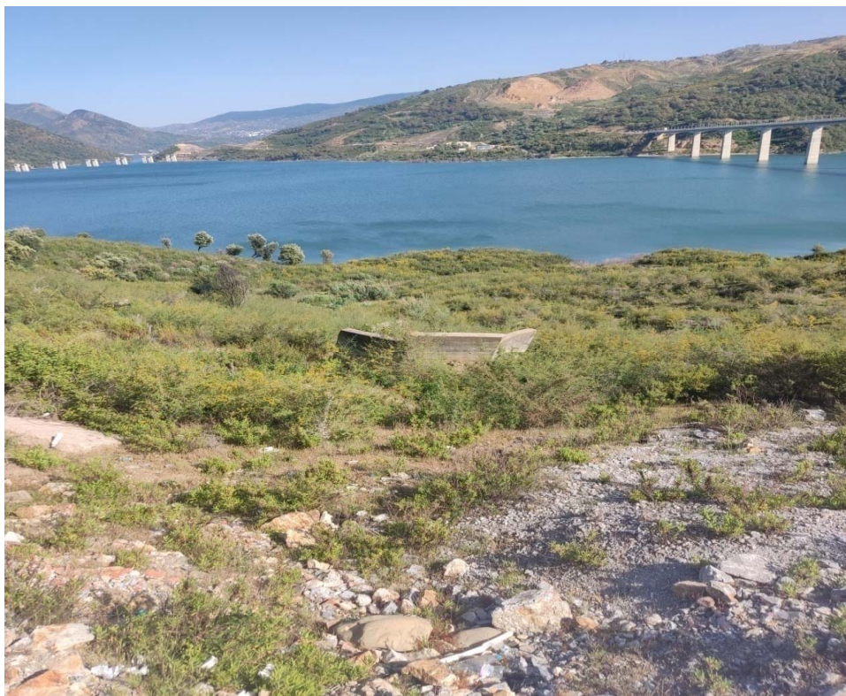
Photo II.4 chute du mur de soutènement
