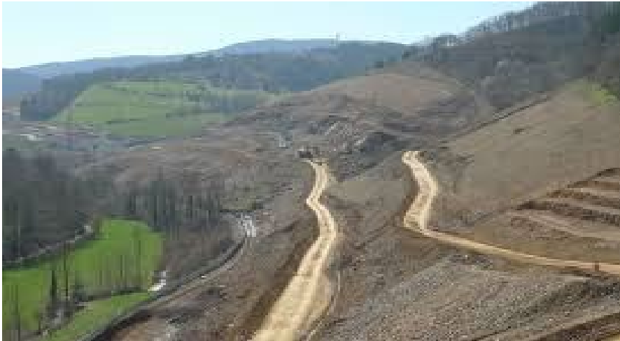
Figure .V. 1. Cas de terrassement.
