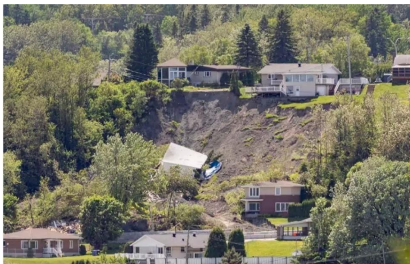
Figure I.16: Construction sur pente ( Saguenay Canada, Le 04 mai 1971).
