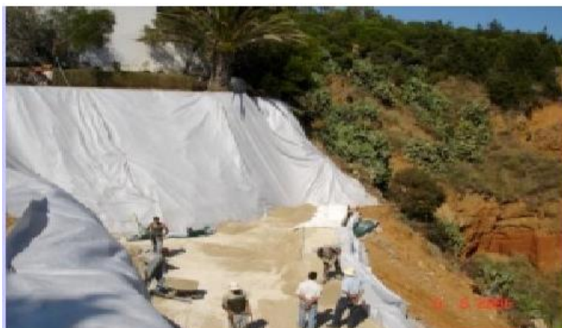
Figure II.17: Renforcement par géotextile ( K.Zaghouani 15-16 Décembre 2006 ).
