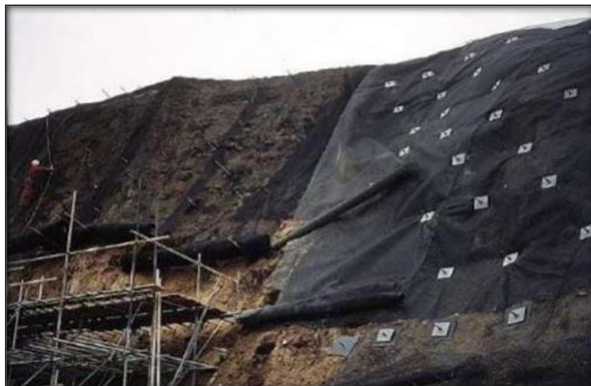
Figure II.07: Un versant stabilisé par clouage.
