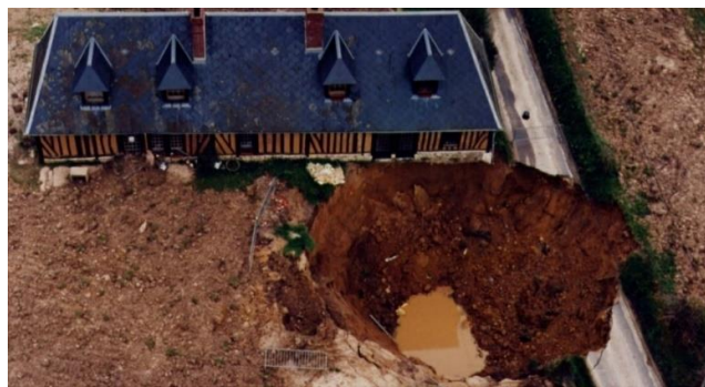
Figure I.02: L'effondrement à la Neuville sur Authou, France en 2001.
