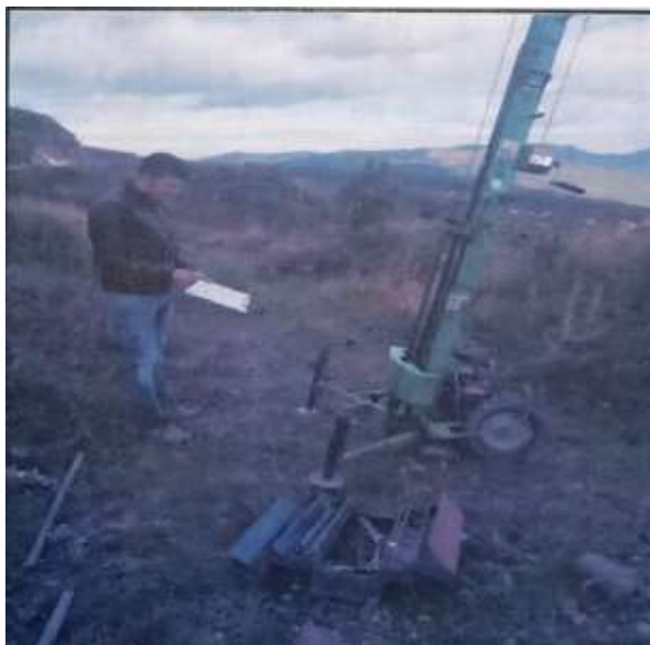
Figure III.10: Implantation d'un point de sondage pénétrométrique.
