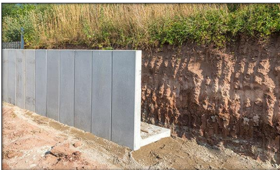
Figure II.13: Mur de soutènement en béton préfabriqué.
