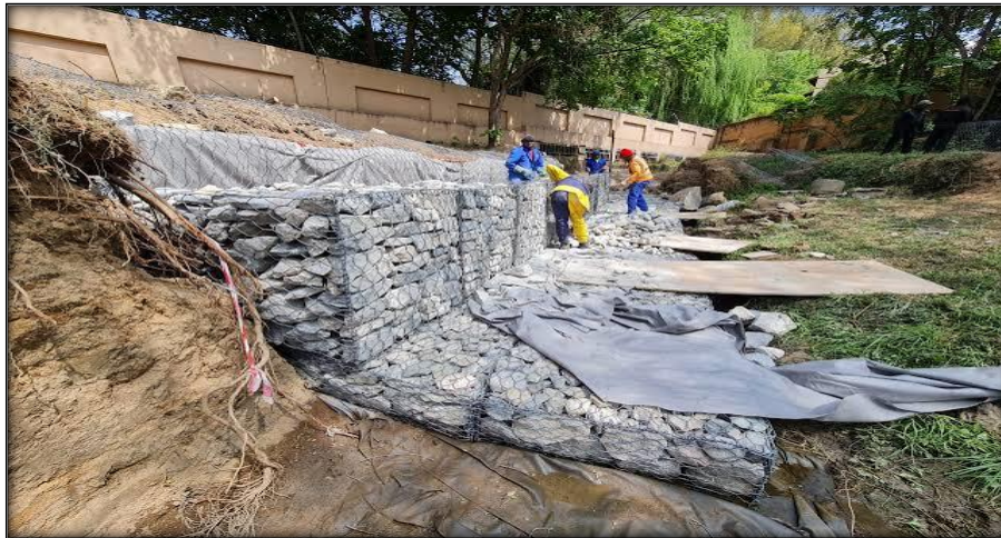
Figure II.18: Exemple de réalisation des gabions en géotextiles.
