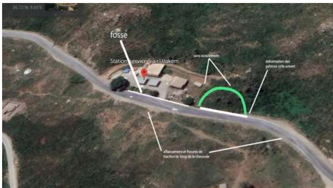
Figure III.06: La morphologie du terrain et les instabilités constatées lors de la visite.
