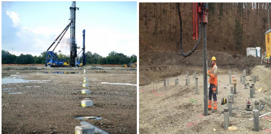
Figure II.08: Exemple de réalisation des pieux battus.
