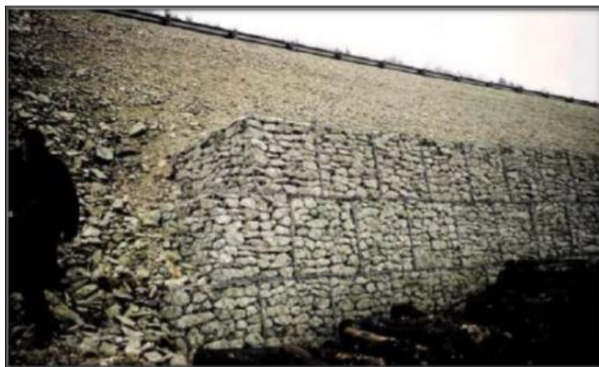
Figure II.19: Exemple d'ouvrage souple (Mur en gabion (Service d'Etude Technique des Routes et Autoroutes (SETRA))).
