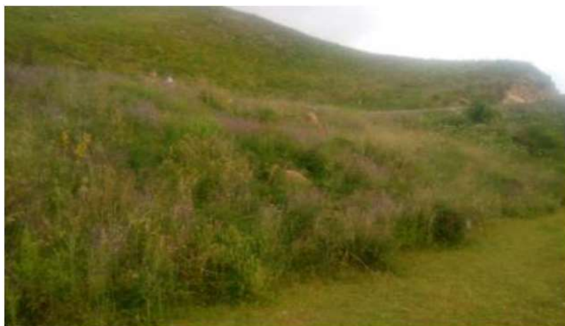
Figure III.08: L'état du talus côté aval de la chaussée avec absence de déplacement visible du terrain.
