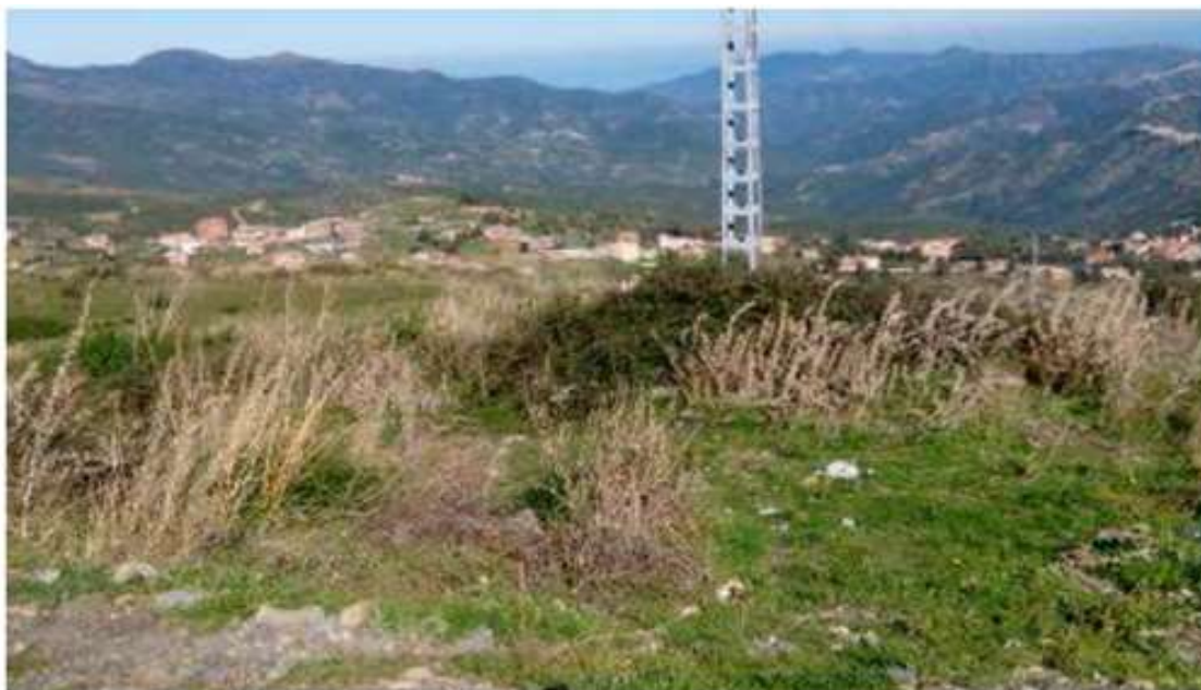
Figure III.07: Poteau électrique stable non affecté par le glissement côté aval.
