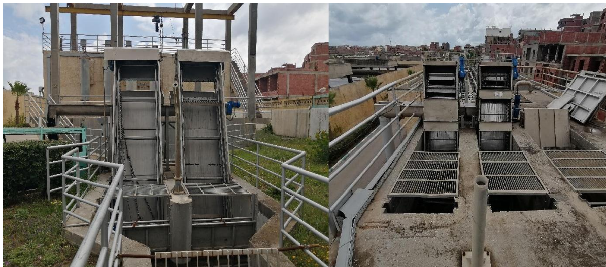
Figure II.8 : Dégrilleur grossier
