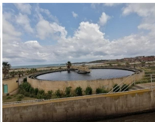
Figure II.14 : bassin de décantation
