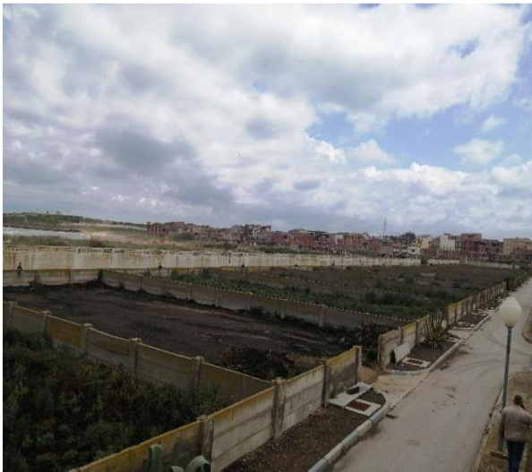
Figure II.15 : Lits de séchage des boues
