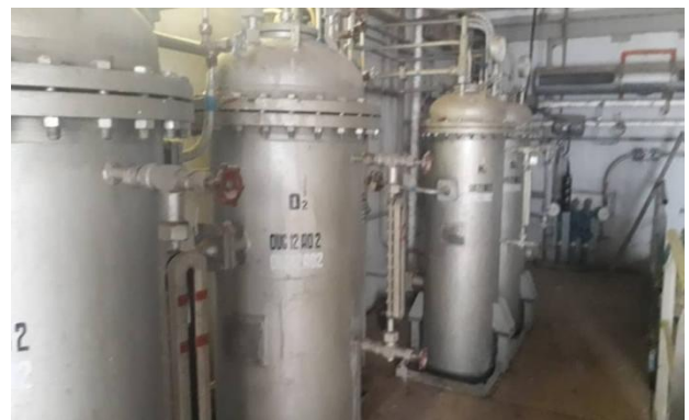
Figure II.2 : Électrolyseur de type filtre-presse.
