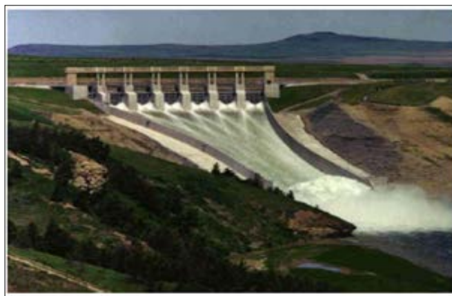
Figure III.01 : Évacuateur de crues à écoulement libre [13]
