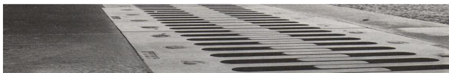
Figure 11.6. joint de chaussée (type WPalu. 300).
