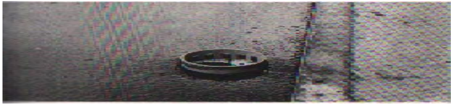
Fig. 11.7. Gargouille
