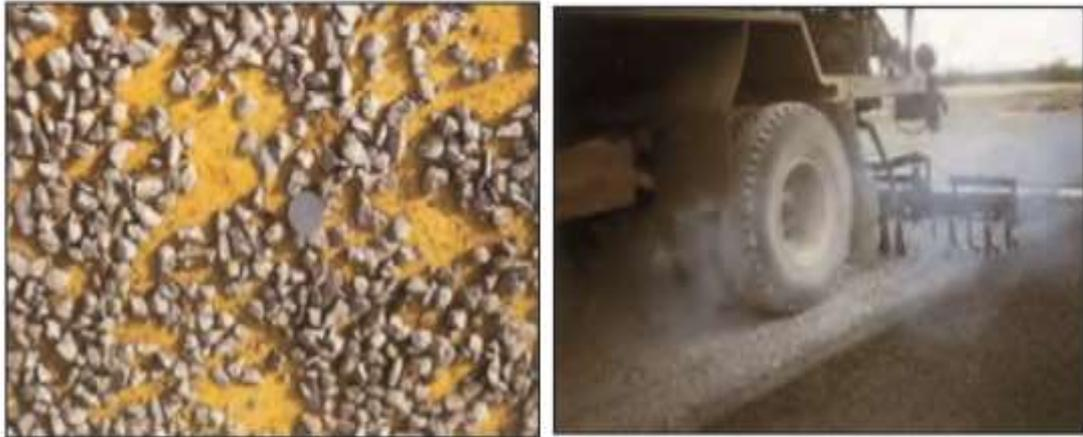
**Figure 2.12 : Protection superficielle en sols fins traités par un enduit de cure clouté.**
