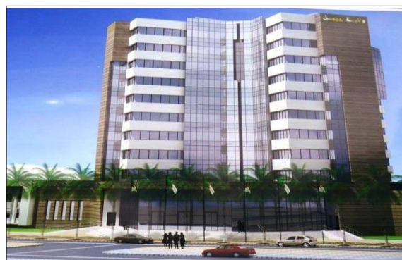
Figure V.13 : Le nouveau siège de la wilaya de Jijel ( Source : ENTREPRISE SARL INDJAZ)
