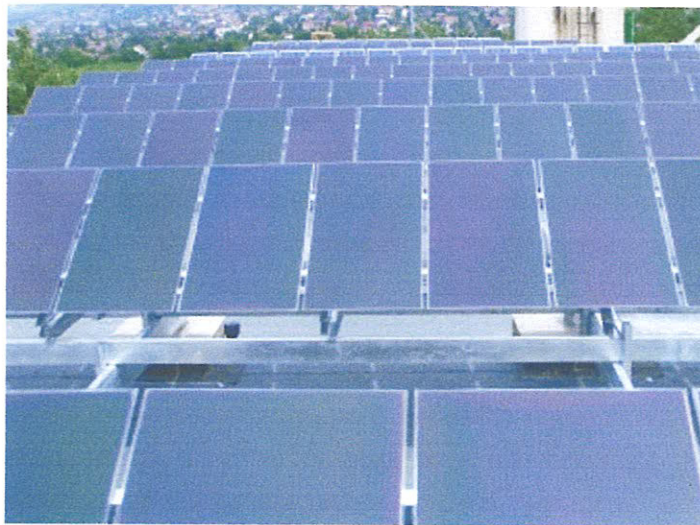
Figure I.12 : Photo des modules photovoltaïque à base des cellules amorphes [20].
