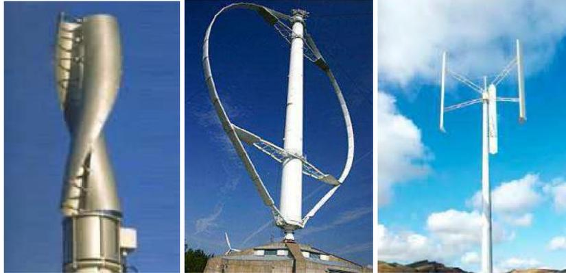
**Figure I.3 :** Exemples de turbines éoliennes à axe vertical.
