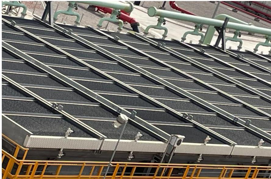
**Figure II. 5.** Echangeurs à faisceaux tubulaire à ailettes autoporté
