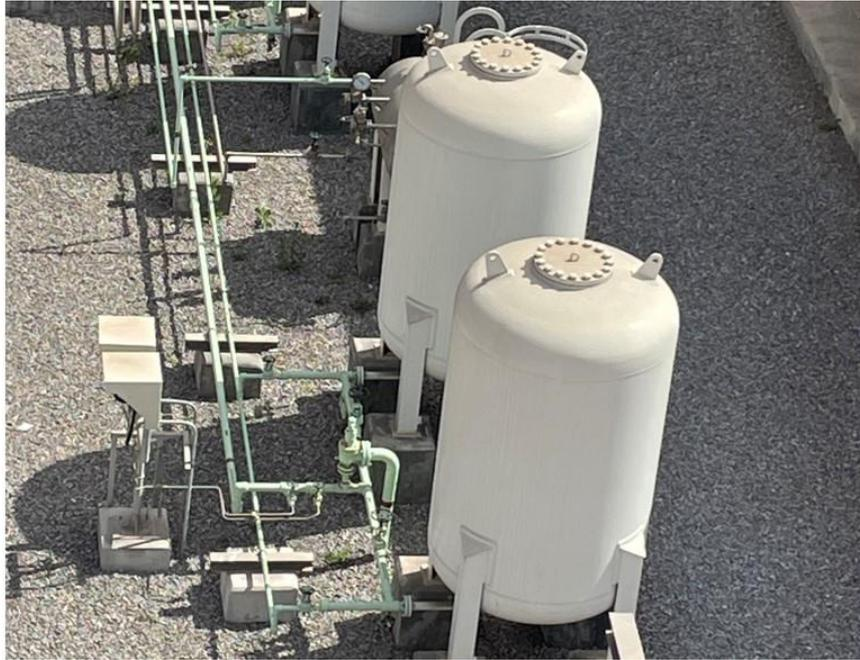
**Figure II. 7.** Vases d'expansion en circuit fermée
