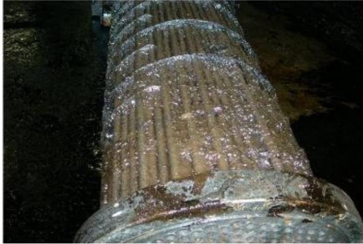
**Figure I. 13.** Formation de Tartre dans un Échangeur
