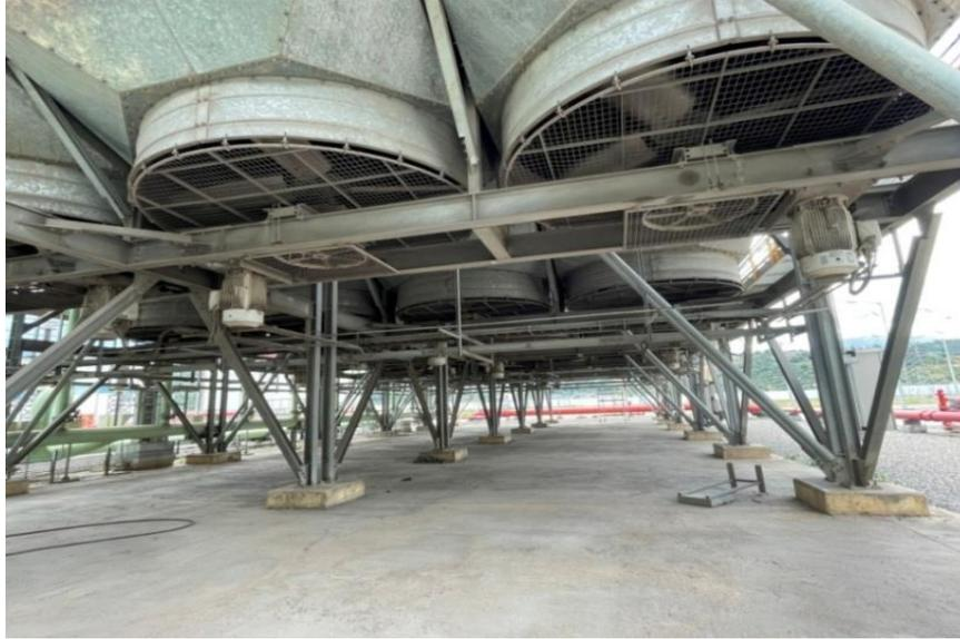
**Figure II. 6.** Ensemble des ventilateurs FIN FAN
