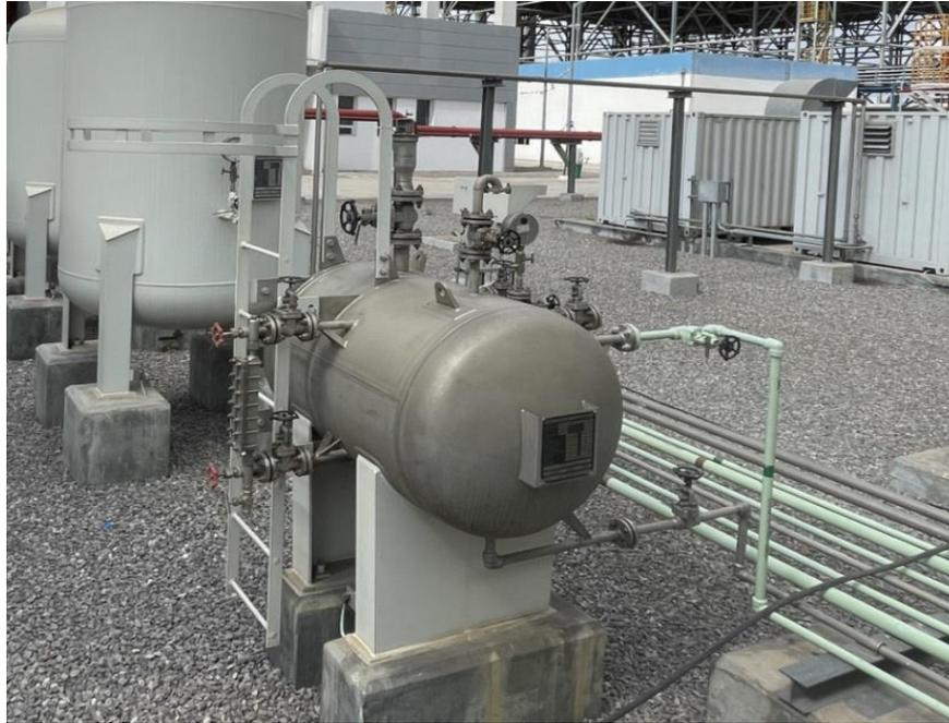
**Figure II. 8.** Réservoir de dosage des produits chimiques
