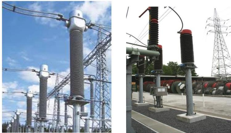
(a) Transformateur de courant      (b) Transformateur de tension
