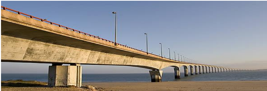
Figure I.14 : Pont de l'île de Ré.
