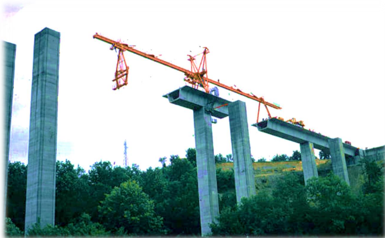
Figure V.1. Pont construit par encorbellement en voussoirs préfabriqués posés à la poutre de lancement
