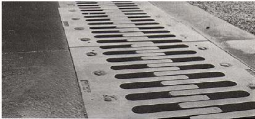
Figure XII.1. Joint de chaussée.
