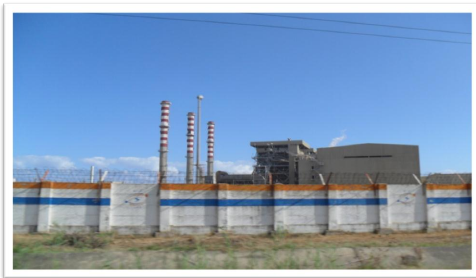
Photo 3. La centrale électrique d'El Achouat
