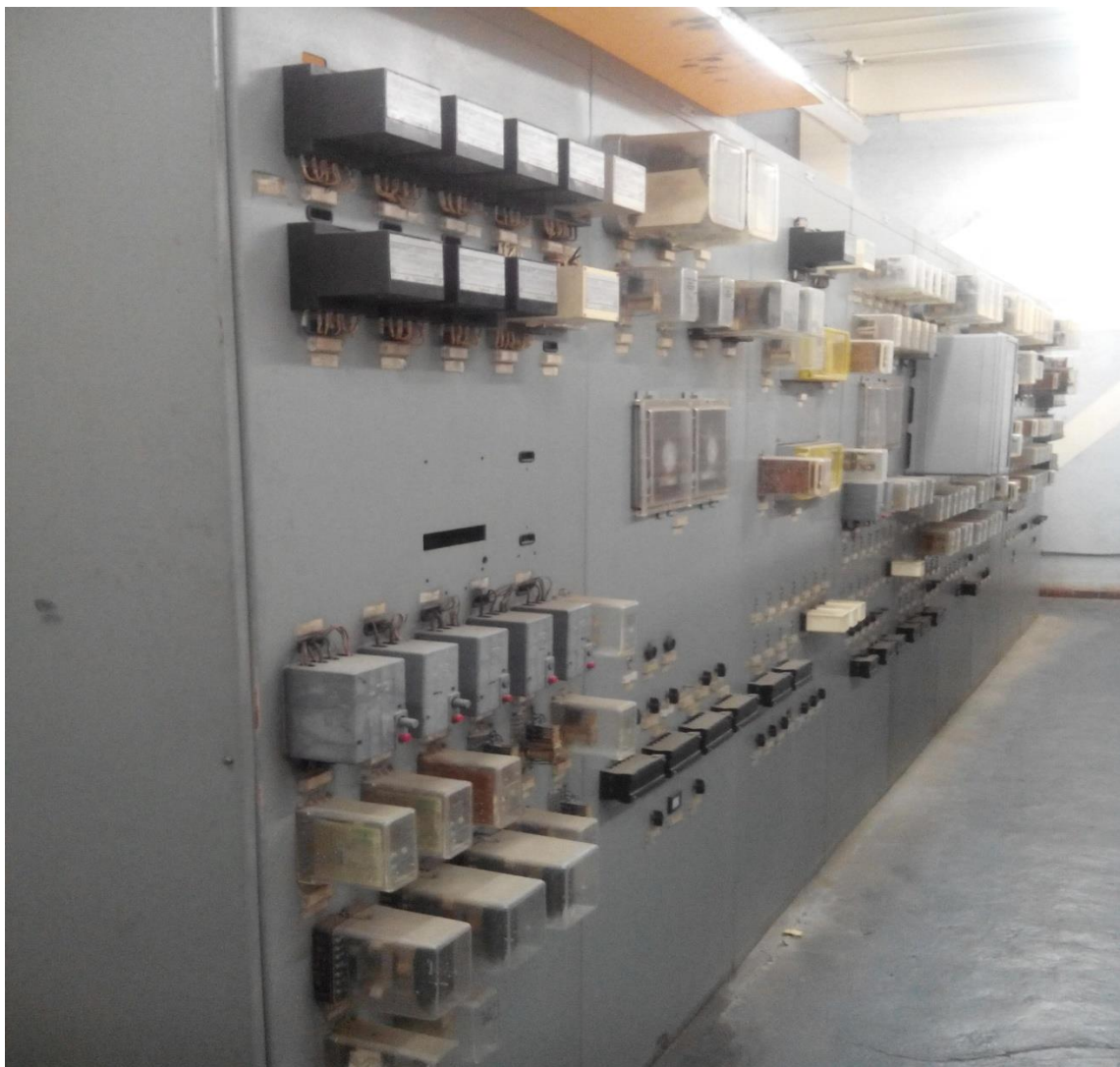
Figure IV -2 : système de surveillance d'alternateur et transformateurs
