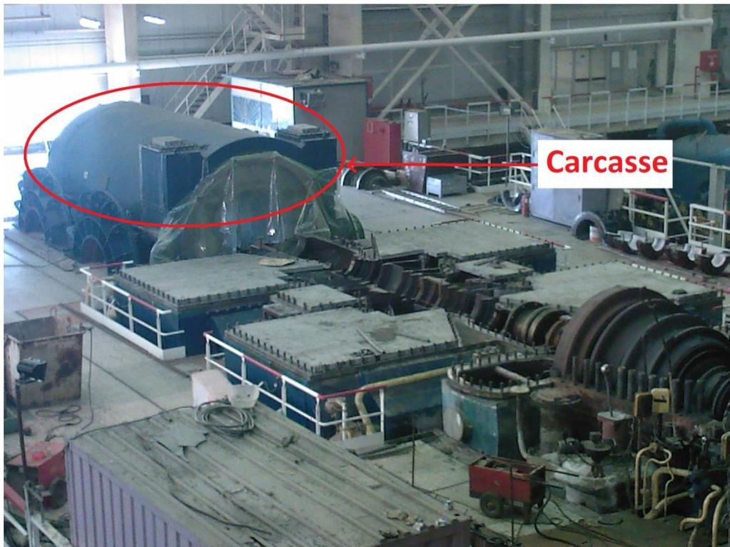
Figure I.13. Carcasse du turboalternateur.
