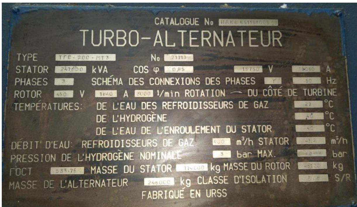
Figure I.14. Plaque signalétique du TIB-200-MT3
