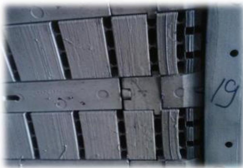
Figure II.11. Trous de ventilation dans le stator.
