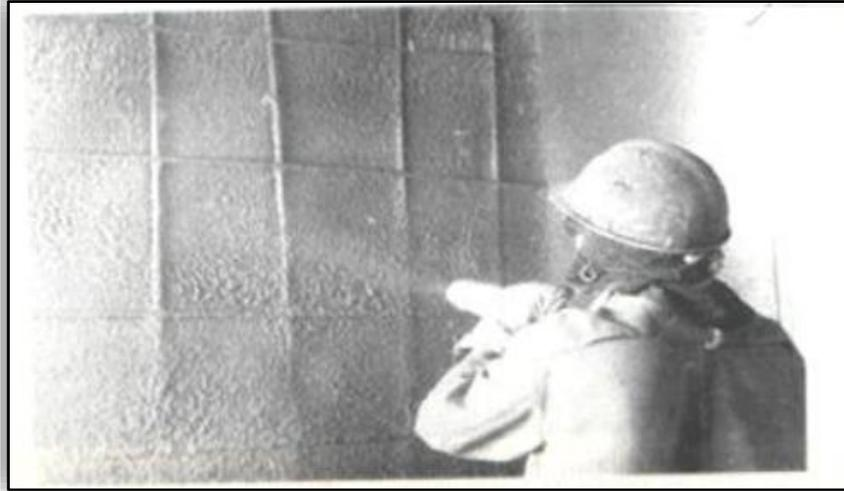
**Figure I.17** : Le béton de sable en projection (Projection sur surface ancienne) [17].
