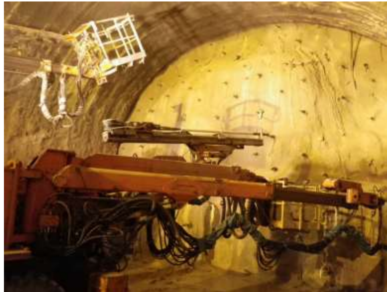
Figure III.8. Mise en place des tubes de renforcement par Machine (Jumbo)
