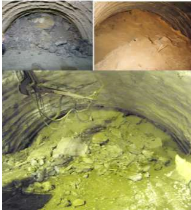
Figure. II.6. Eboulement du front de taille d'un tunnel
