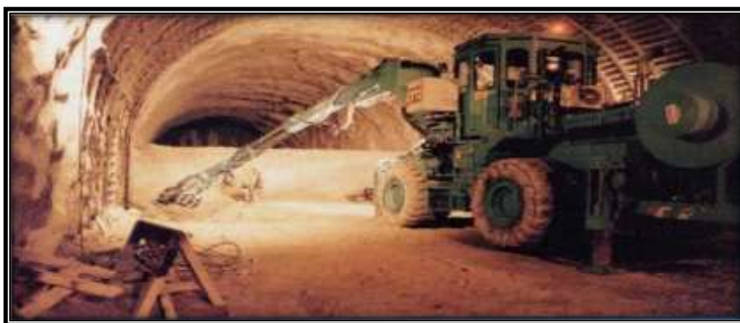
Figure I.8 : Méthode de la demi-section
