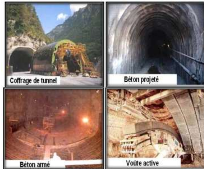
Figure.I.10. Types de soutènement et de revêtement des tunnels
