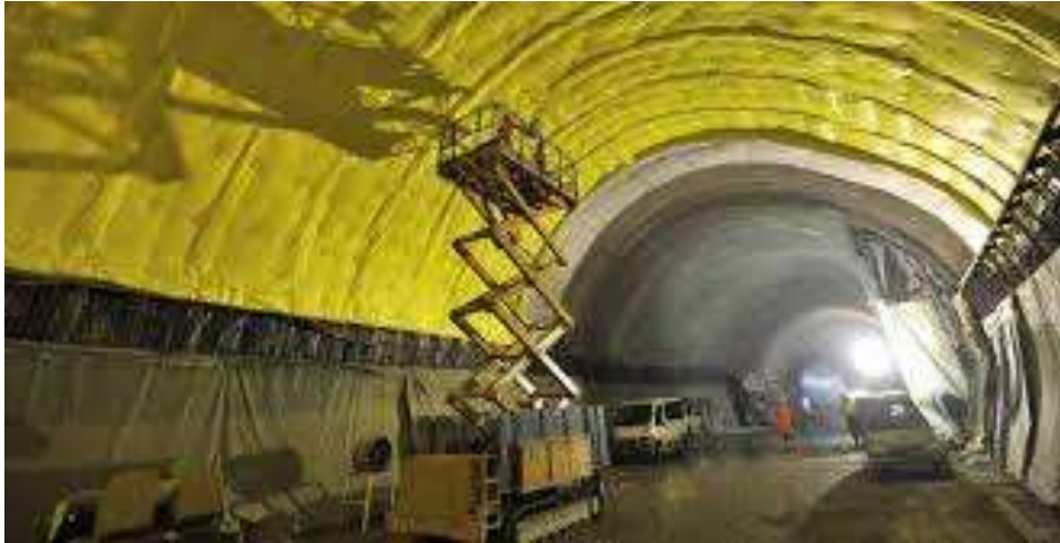
Figure I. 11. Mise en place du dispositif d'étanchéité.
