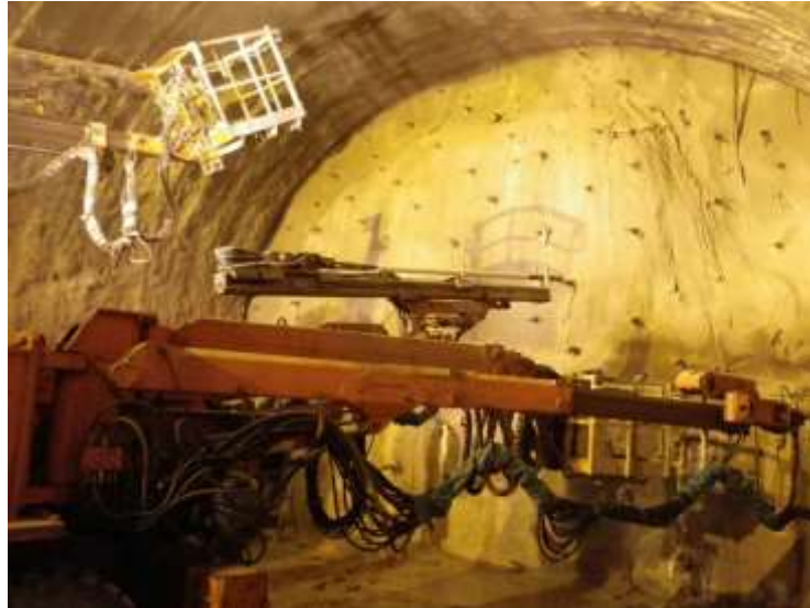
Figure II.8. Mise en place des tubes de renforcement par Machine (Jumbo)
