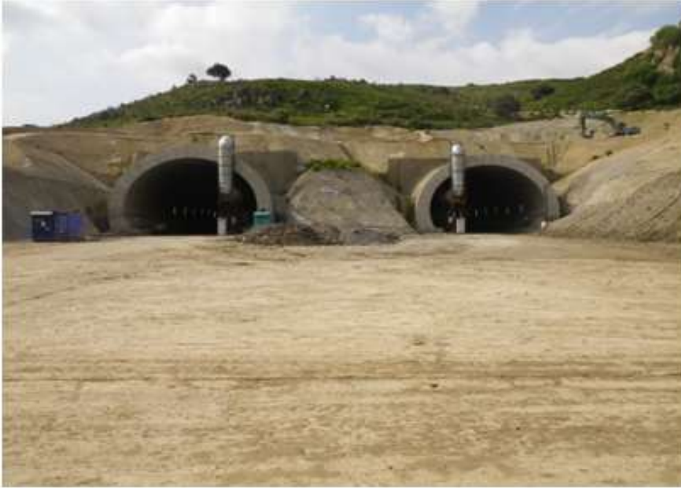
Figure III.1 : Portail Sud de tunnels T4
