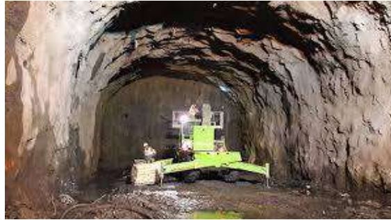
Figure I.7 : Méthode à pleine section
