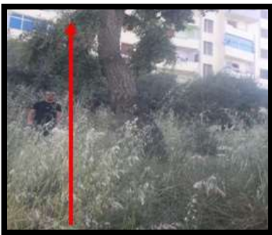
Photo .08.Inclinaison des arbres de glissement de terrain
