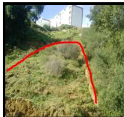
Photo. 04. ligne de rupture de glissement terrain
