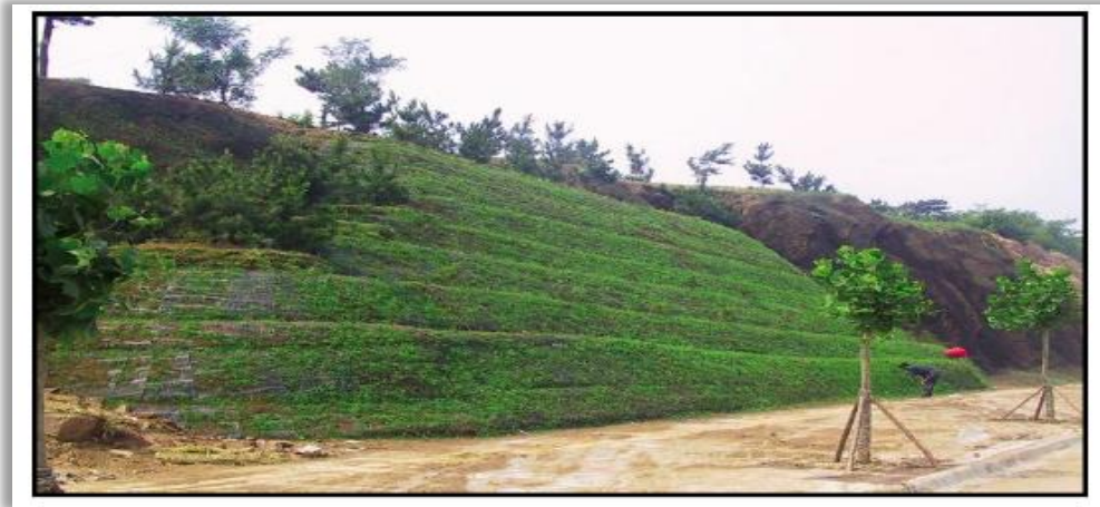
Figure II.9 : L'implantation des plantes dans un talus.
