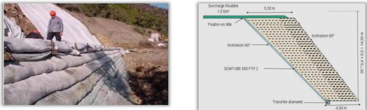
FigureII.19 : Chantier en cours de réalisation utilisant le technique géotextile.
