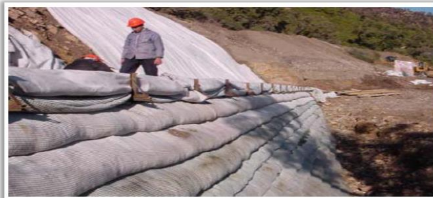
FigureII.12: Parement préfabriqué devant le massif en géotextile.
