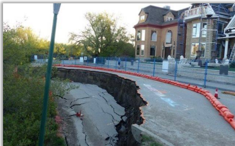
Figure I.2 : Tassement de sol à Saskatoon Canada.
