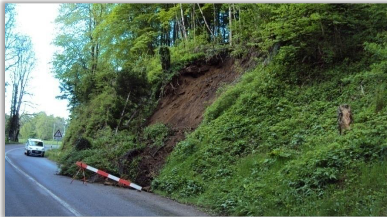
Figure I.14 : Glissement superficiel (Mallettes 2013).
