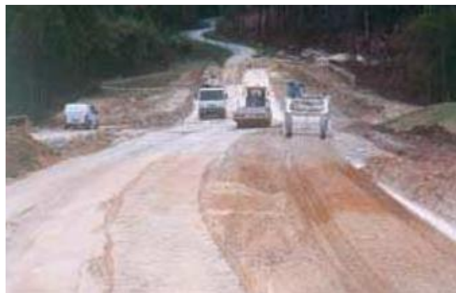
Figure 3.8. Compactage final des sols traités (CIM Béton, 2004 et 2009).
