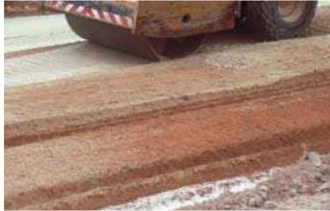
Figure 3.7. L'opération du compactage partiel (CIM Béton, 2004 et 2009).
