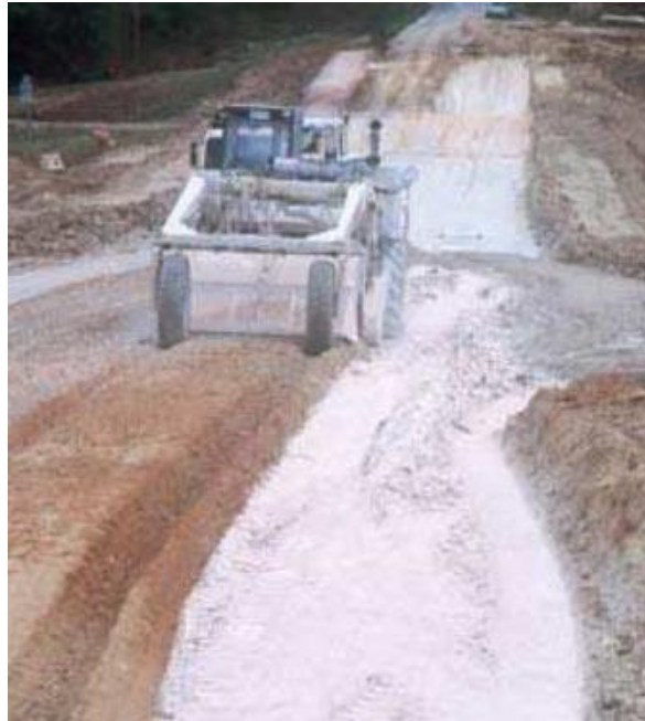
Figure 3.6. Le malaxage du liant avec le sol (CIM Béton, 2004 et 2009).
