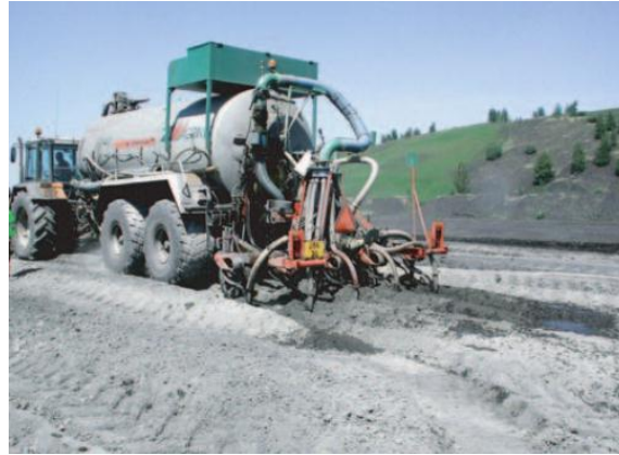
Figure 3.3. Arroseuse enfouisseuse, équipée d'un débitmètre (Rossi et al., 2008)
