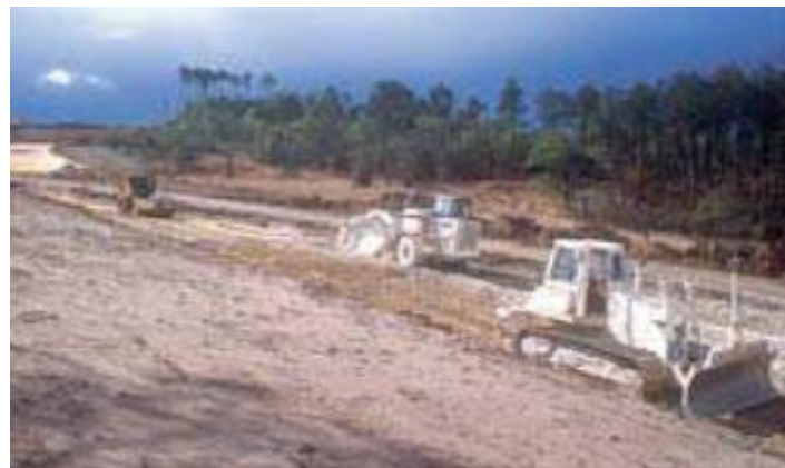
Figure 3.4. Vue d'un chantier en préparation pour un traitement (CIM Béton, 2004 et 2009).
