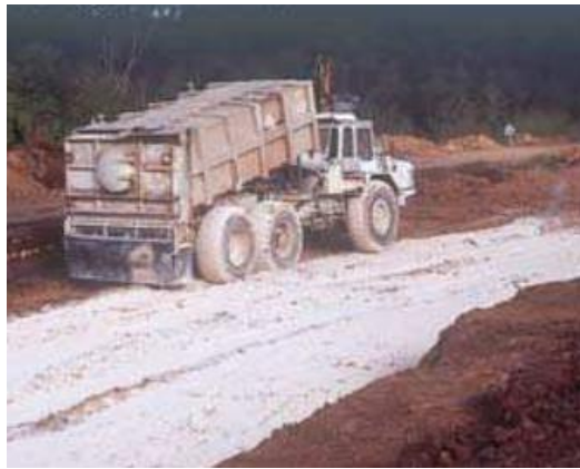
Figure 3.5. La phase de l'épandage du liant sur le sol à traiter (CIM Béton, 2004 et 2009).
