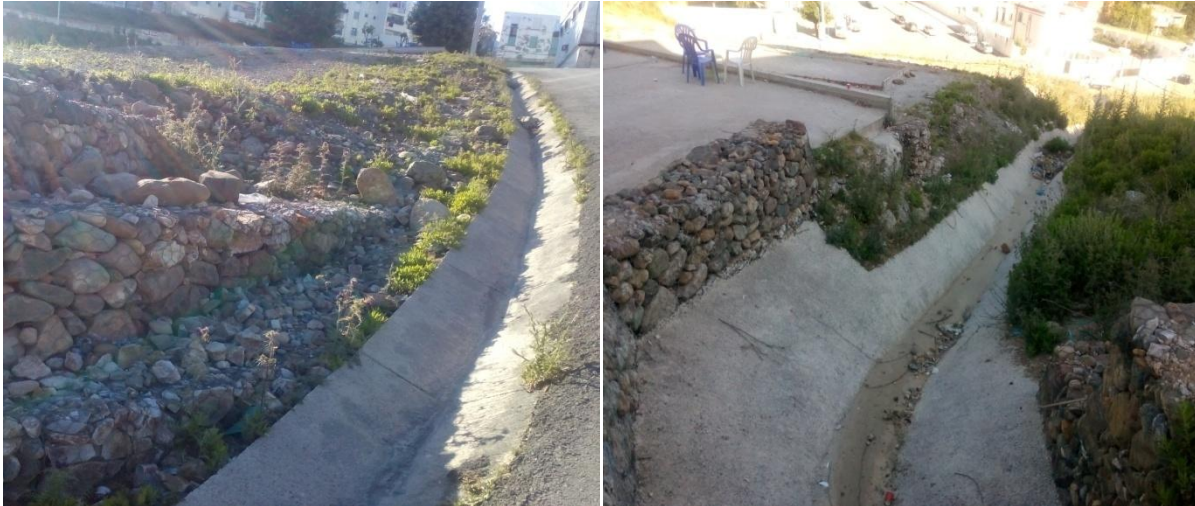
Photo. V.2 : Réalisation des caniveaux.
