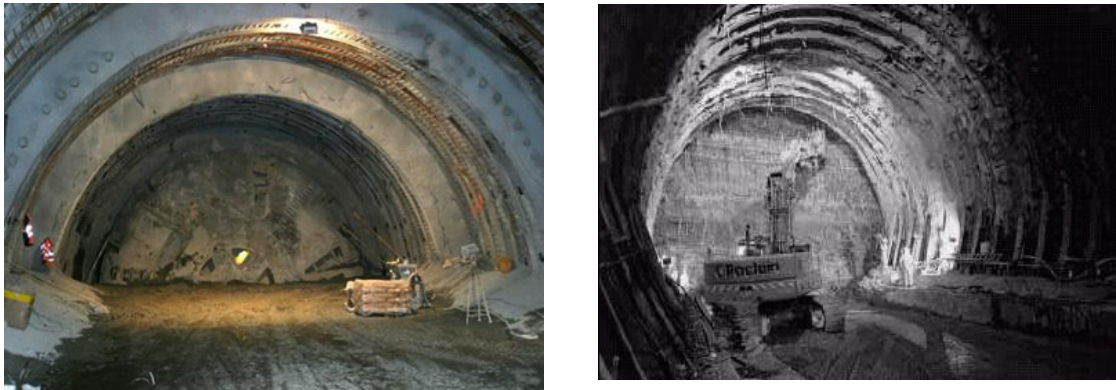
Figure 1.5: Creusement à plein section
