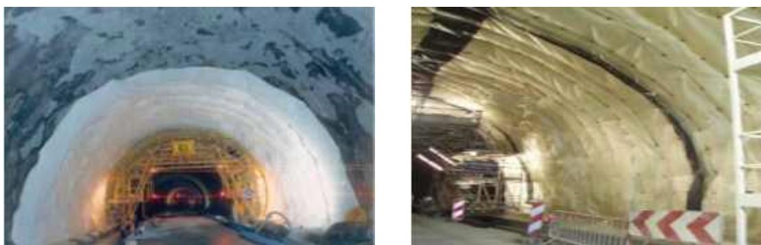
Figure (4.5) : Etanchéité d'un tunnel.
