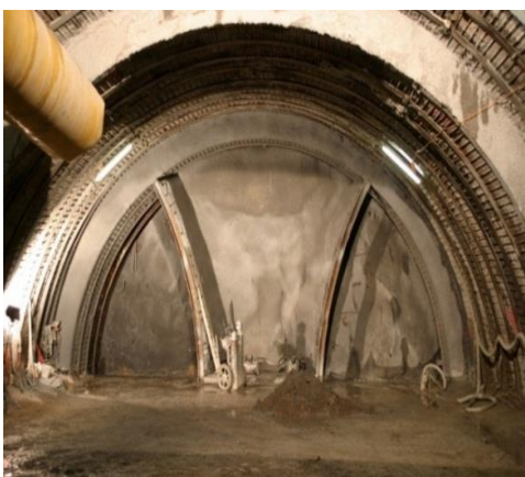
Figure 1.7 : Creusement de la section divisée
