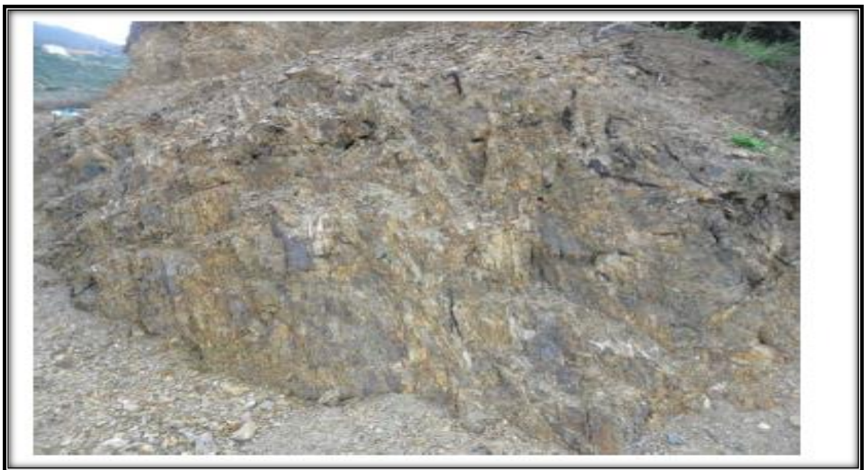
Figure 2.9: Schistes altérés près de forage FT-1 décapage lors de l'ouverture de la piste pour les essais in situ
