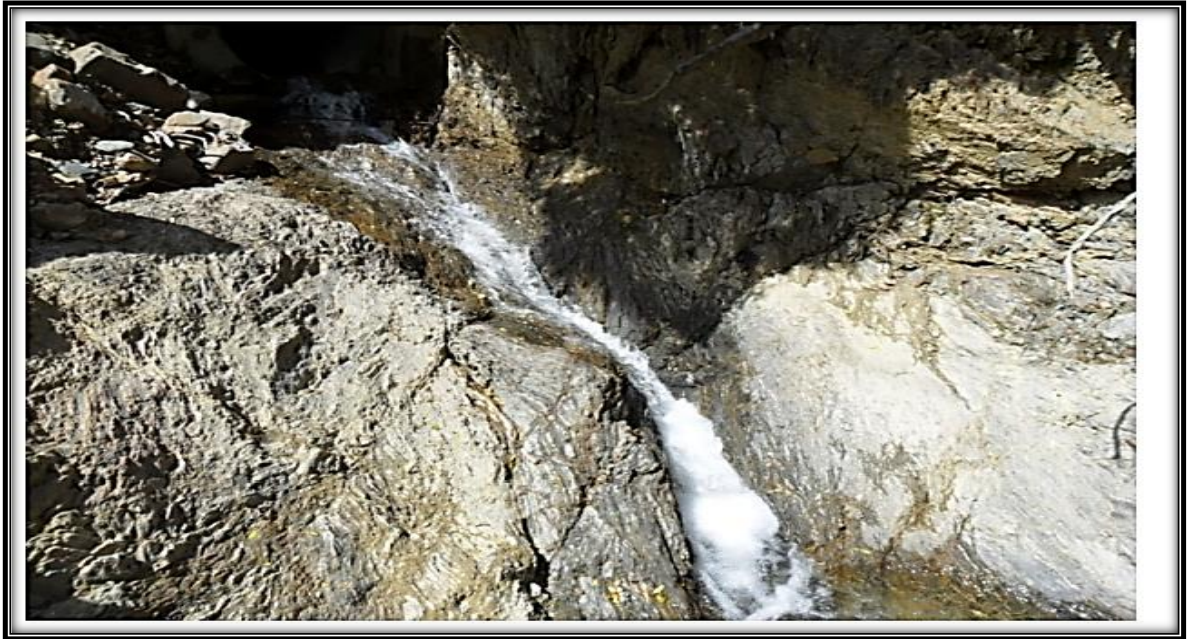
Figure 2.7: Argilite très ferme à dure située à droite du portail sud en allant vers Sétif
