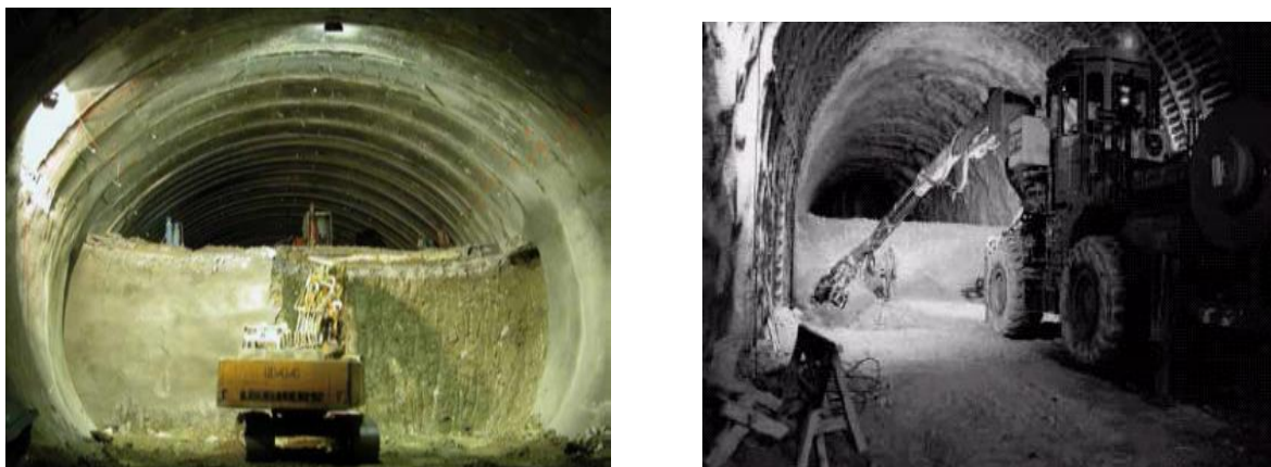
Figure 1.6 : Creusement en demi-section
