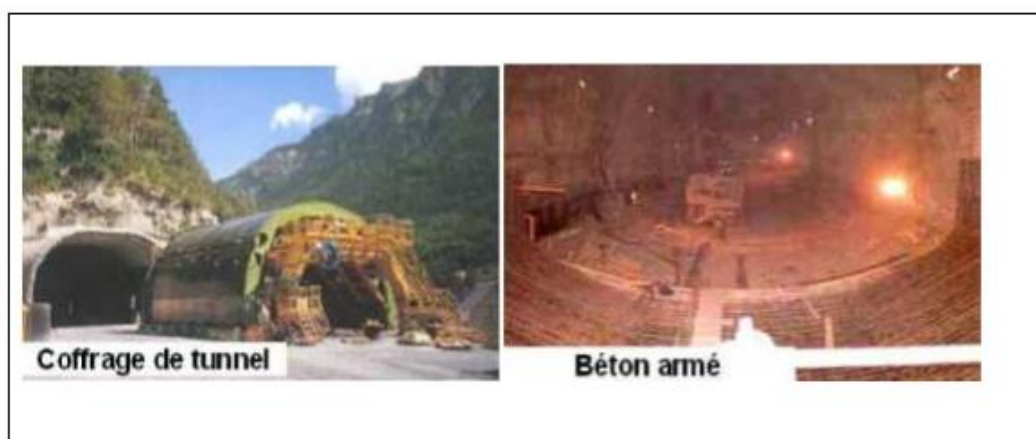
Figure 4.6. Types de revêtement des tunnels
