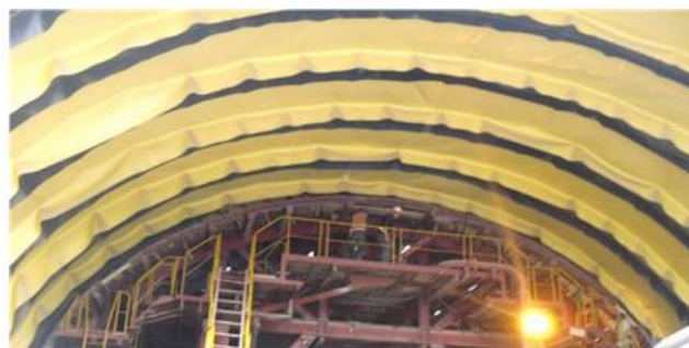
Figure 4.9: Mise en place du dispositif d'étanchéité
