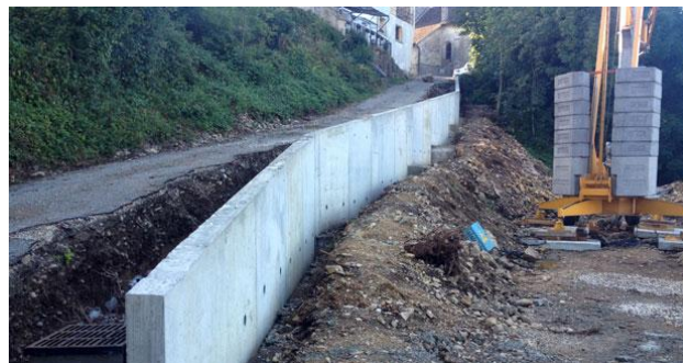
Figure V.15 : Mur de soutènement. [28]
