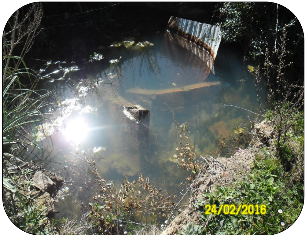
Figure II.6 : Le puits détérioré prise en 24/02/2016.
