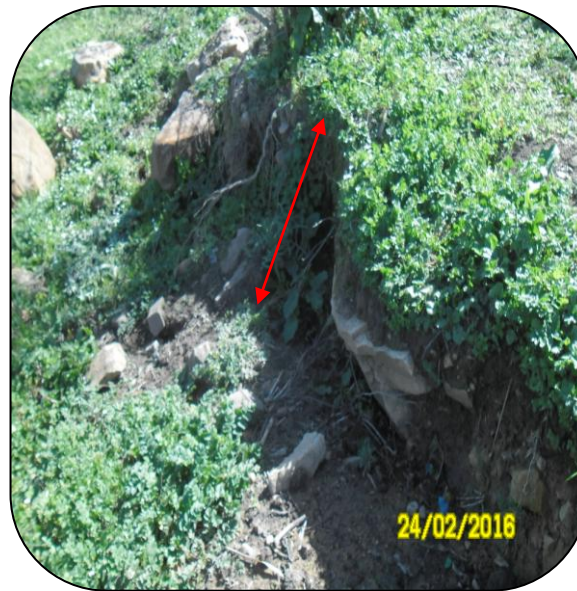
Figure II.9 : La ligne de rupture.
