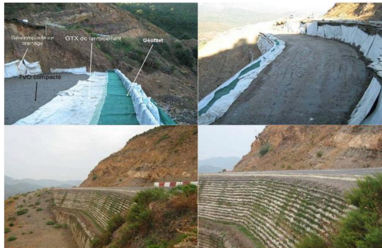
Figure V.11 : Renforcement des talus par nappe géotextiles.[28]
