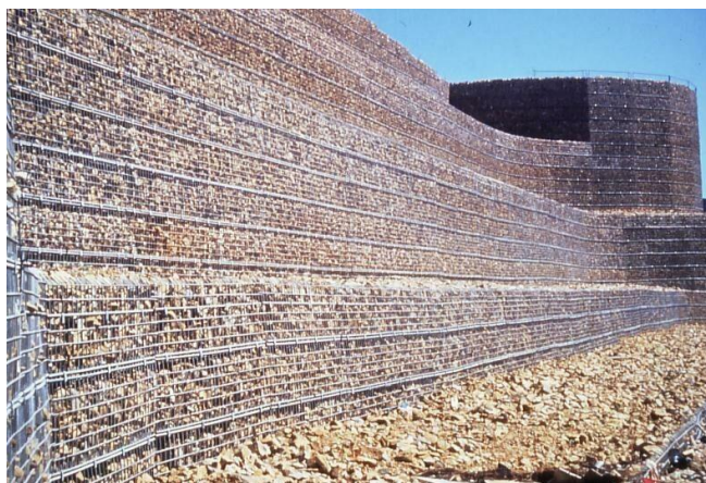
Figure V.9 : Mur en gabions.[18]
