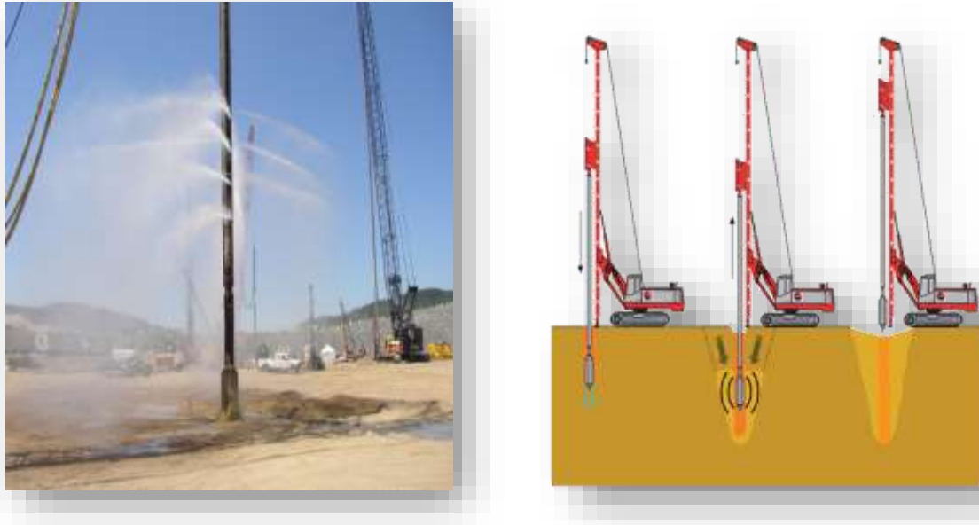
Figure I.20 : Renforcement Par amélioration dans la masse.
