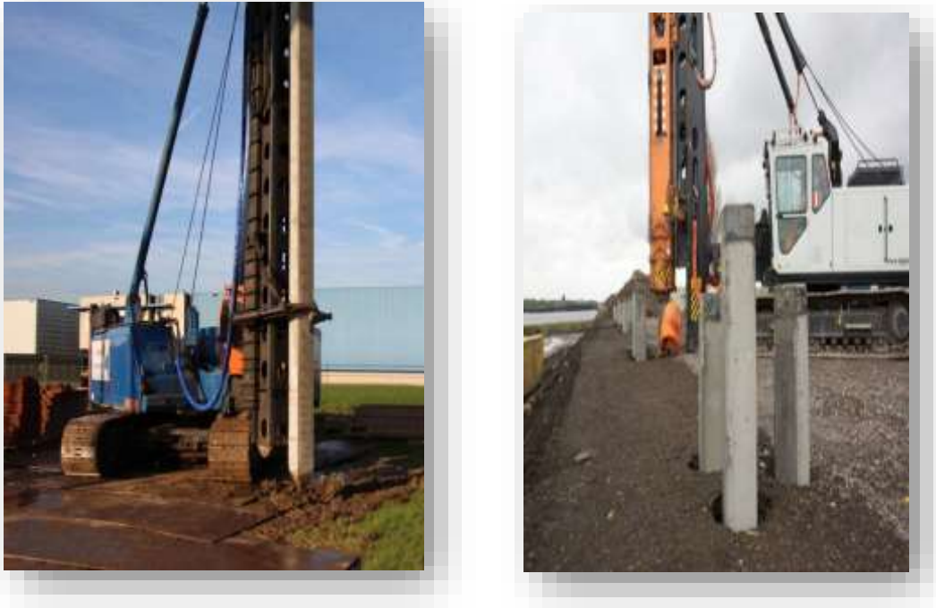
Figure I.15: Pieux battus en béton préfabriqués.
