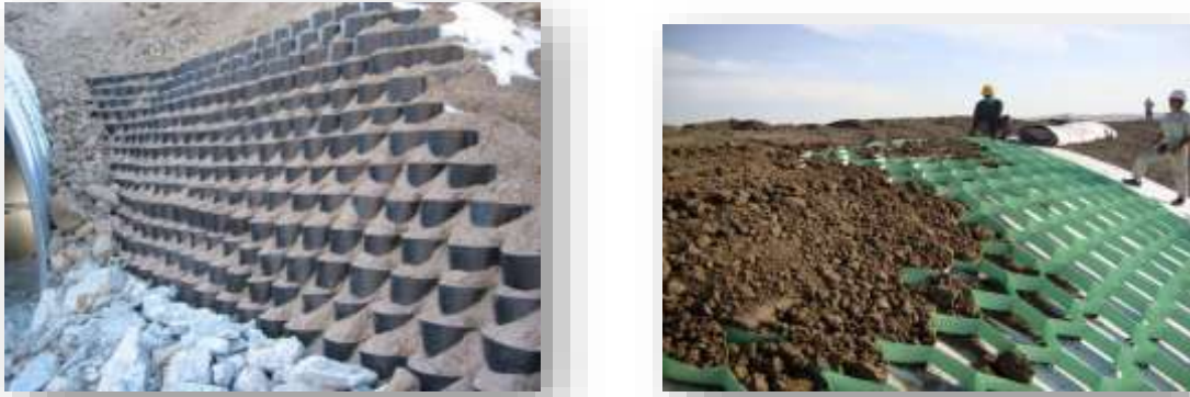
Figure I.8 : Géosynthétiques alvéolaires.
