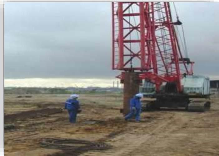
Figure I.14 : Pieux métalliques. Nouvelle minoterie Kadji, Cameroun 2002.
