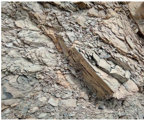
Fig. III-11 : Marne noirâtre consolidée d'aspect friteuse
