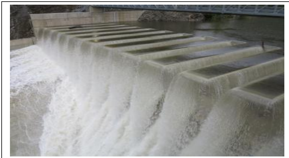
Figure I-16 : Déversoir en touches de piano - Barrage Malarce – France.[15]
