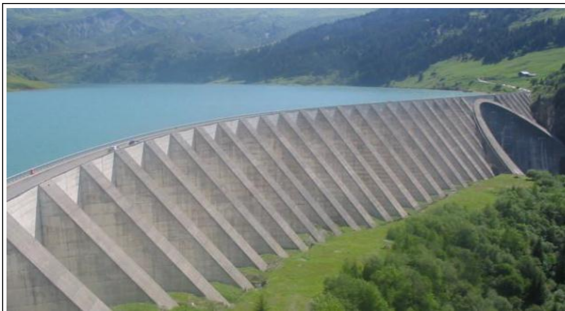
Figure I-5 : barrage à contreforts.[13]
