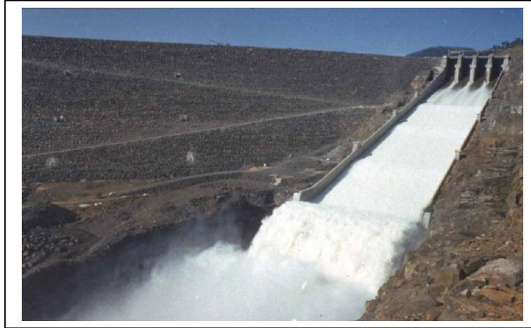
Figure I-15 : Évacuateur à écoulement libre. [13]
