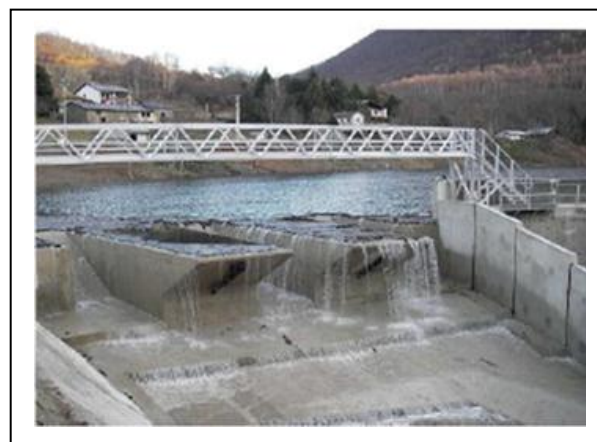
Figure I-22 :Déversoir en touches de piano.[9]
