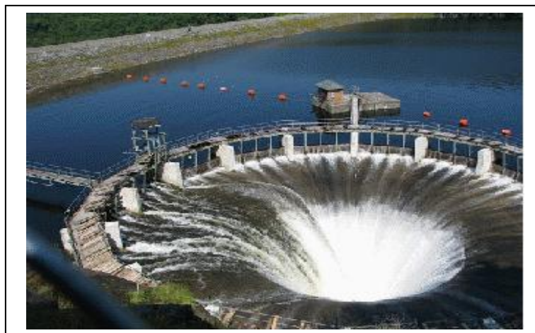
Figure I-14 :Évacuateur de crues en charge. [13]
