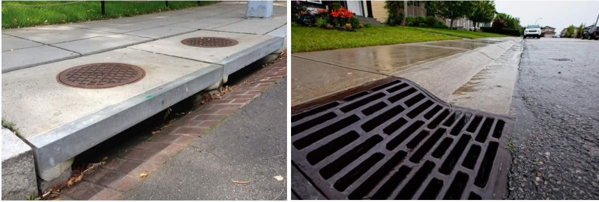
Figure I.21. Bouches d'égout
