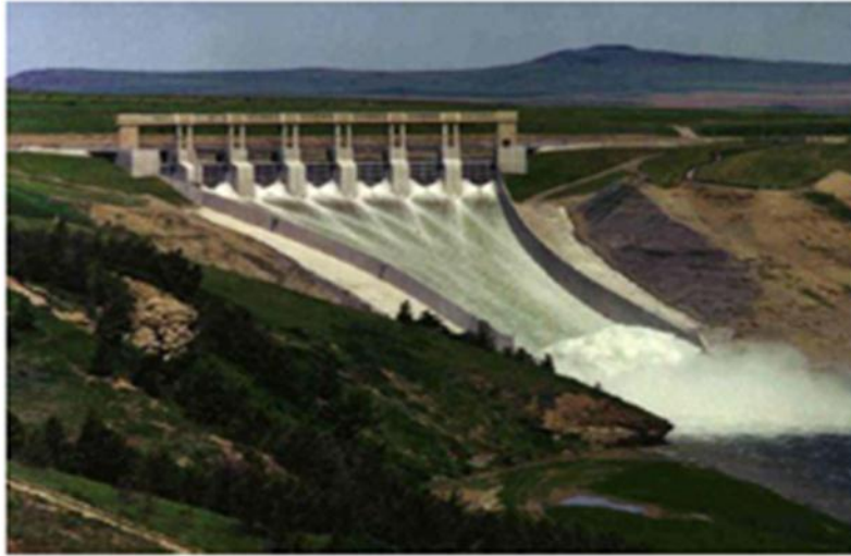
Figure (I-10) : Évacuateur de crues de surface. [4]
