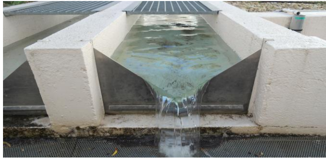
Figure (I-18) : Déversoir triangulaire à paroi mince.
