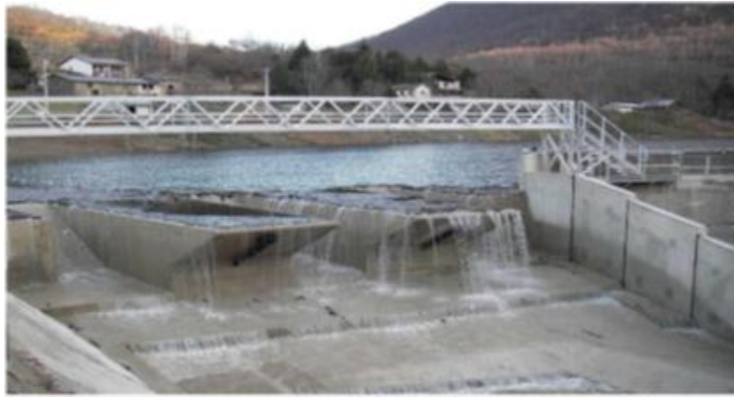
Figure (I-27) : Piano Key Weir sur barrage Goulours (EDF – France).
