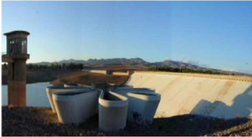
Figure (I-17) : Evacuateur en puits marguerite. [9]
