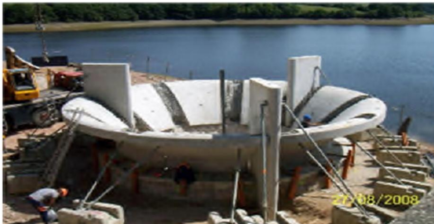
Figure (I-16) : Évacuateur en puits circulaire. [10]
