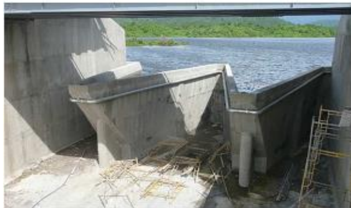
Figure (I-25) : Déversoir en labyrinthe du barrage de Song Mong (Viêt Nam).
