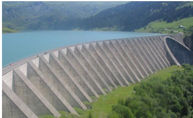
Figure (I-4) : Barrage à contreforts de d'Albertville, Rhône-Alpes, France (1955-1962). [4]
