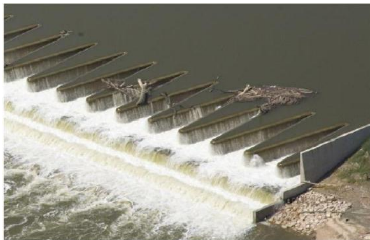
Figure (I-24) : Déversoir non rectiligne (barrage Texas, USA).
