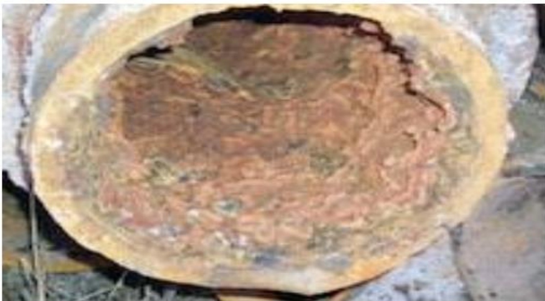
Figure I.6 : Vieillessement des canalisations [29]
