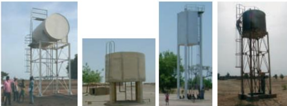
Figure I.3 : Illustration de la variété des réservoirs surélevés en termes de forme, taille et hauteur [30]
