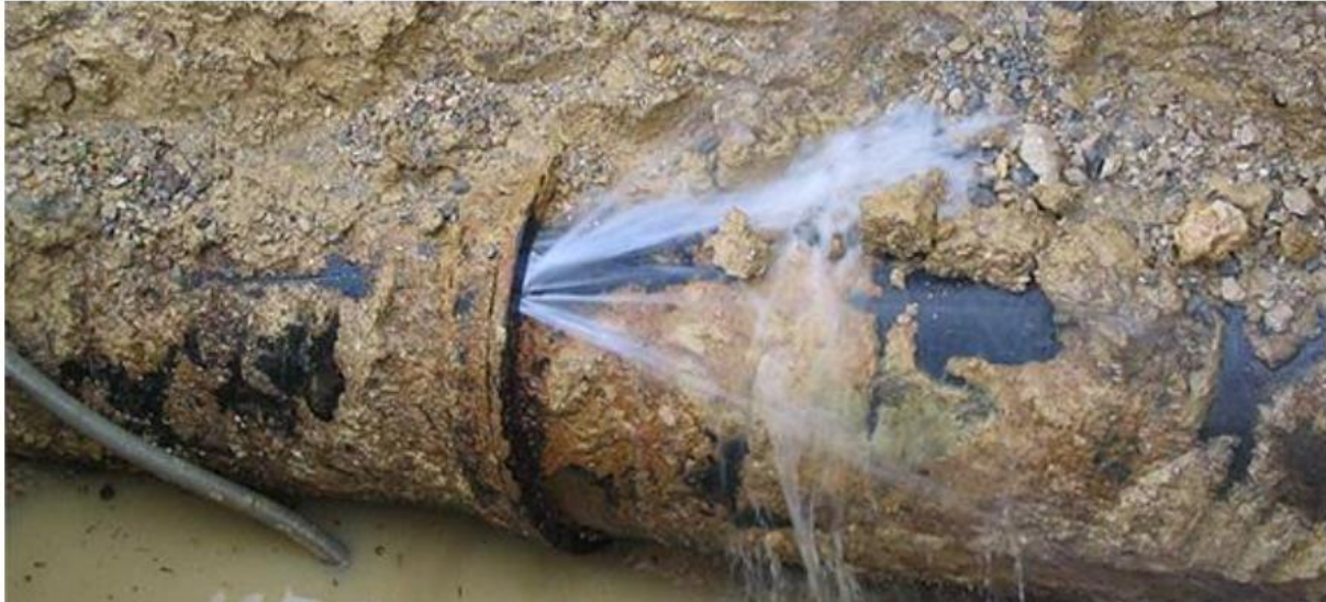
Figure I.7 : Vieillesse des joints à cause des Fuites dans les conduites [29]
