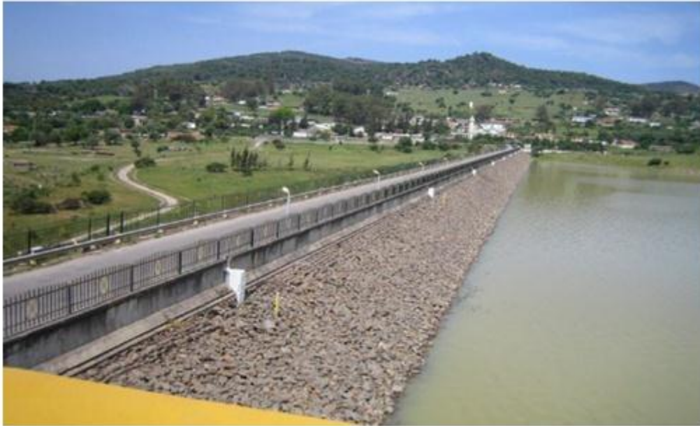
Figure II. 2 : la digue de cheffia.
