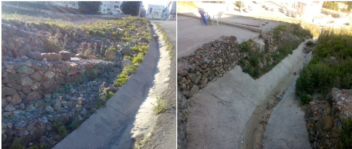
Photo.VI.5 : Réalisation des caniveaux
