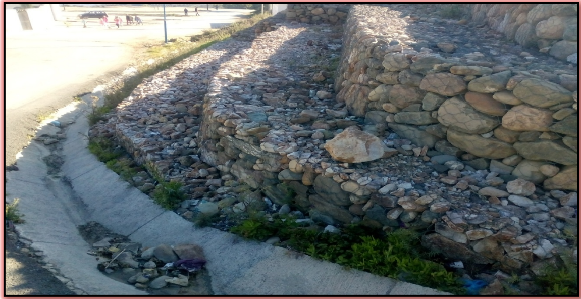
Photo.VI.6:La mise en place du gabionnage
