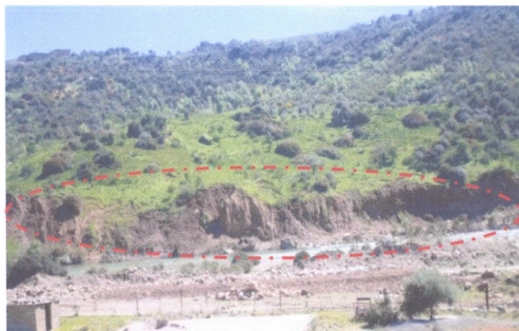
Figure VII.1: Erosion active des berges à lithologie marneuse (Oued El Kébir-Sidi Maarouf).
