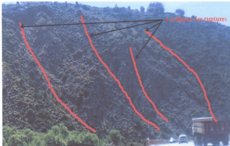
Figure VII.2 : Lignes de rupture potentielles au surplomb des berges(2015).
