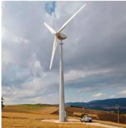
Figure I-8 : Les éoliennes à axe horizontal.
