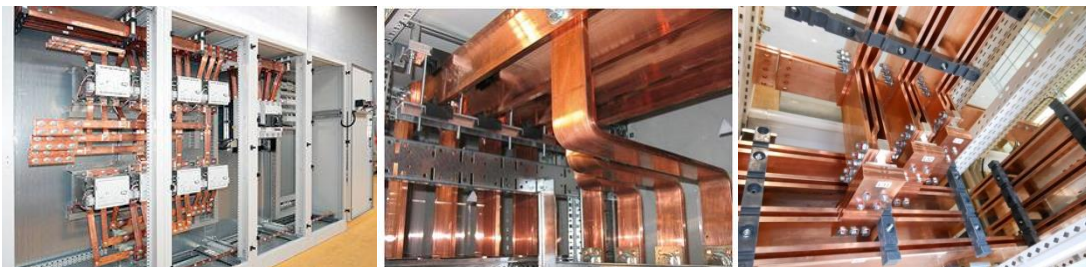
Figure 7 : images de quelques configurations de jeux de barres BT (TGBT) de profilés I
