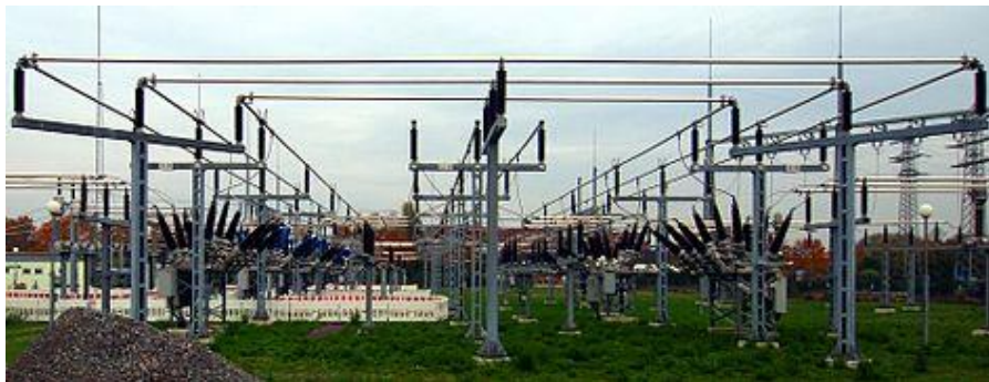
Figure 5 : Image d'un jeu de barre HT aérien de profilé O et en configuration U
