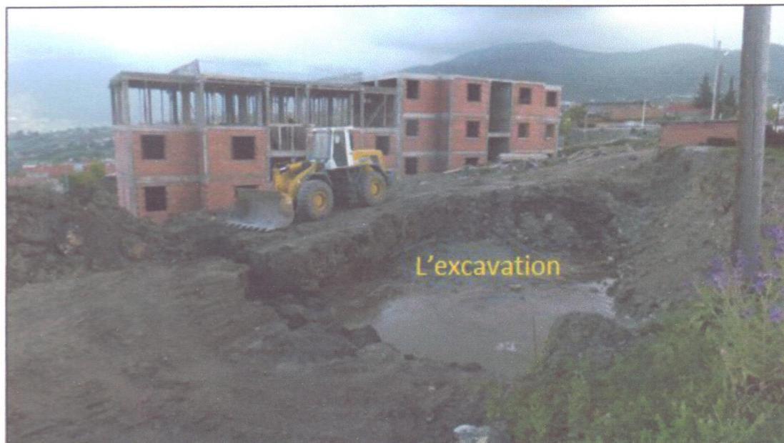
**Figure V.10.** Travaux d'excavations et de déblaiement entamés en aval du site des 24 logements situés à quelques mètres (05/05/2013).
