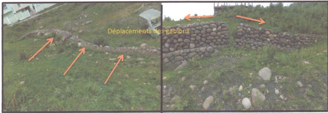
**Figure IV.5.** Déplacement des gabions par suit aux mouvements des terres (05/05/2013).
