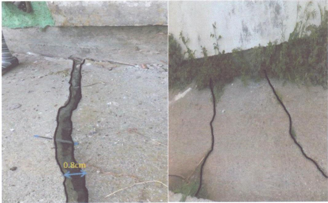
**Figure.V.14** Fissuration d'une dalle en béton (05/05/2013).
