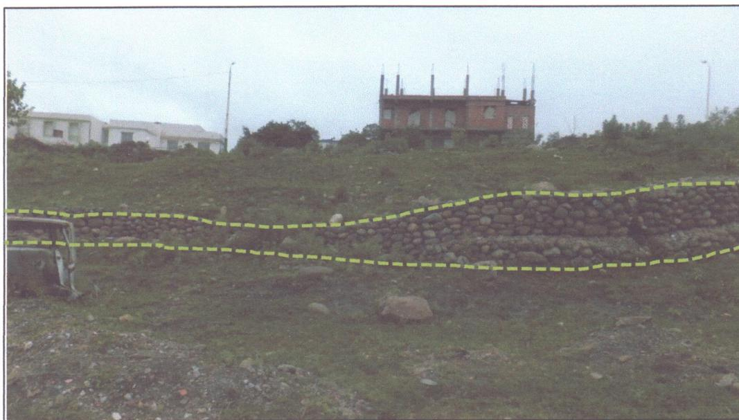
**Figure.IV.10.** Gabionnage emporté par le mouvement de terrain (05/05/2013).
