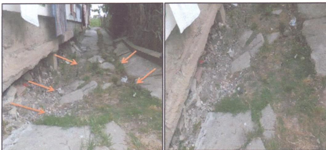
**Figure.V.11.** Détériorations et affaissement du dallage autour de l'immeuble (05/05/2013).
