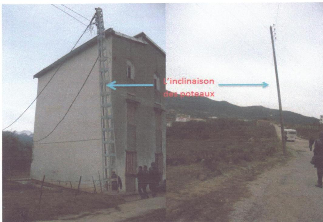
Figure.V.16. L'inclinaison des poteaux (05/05/2013).
