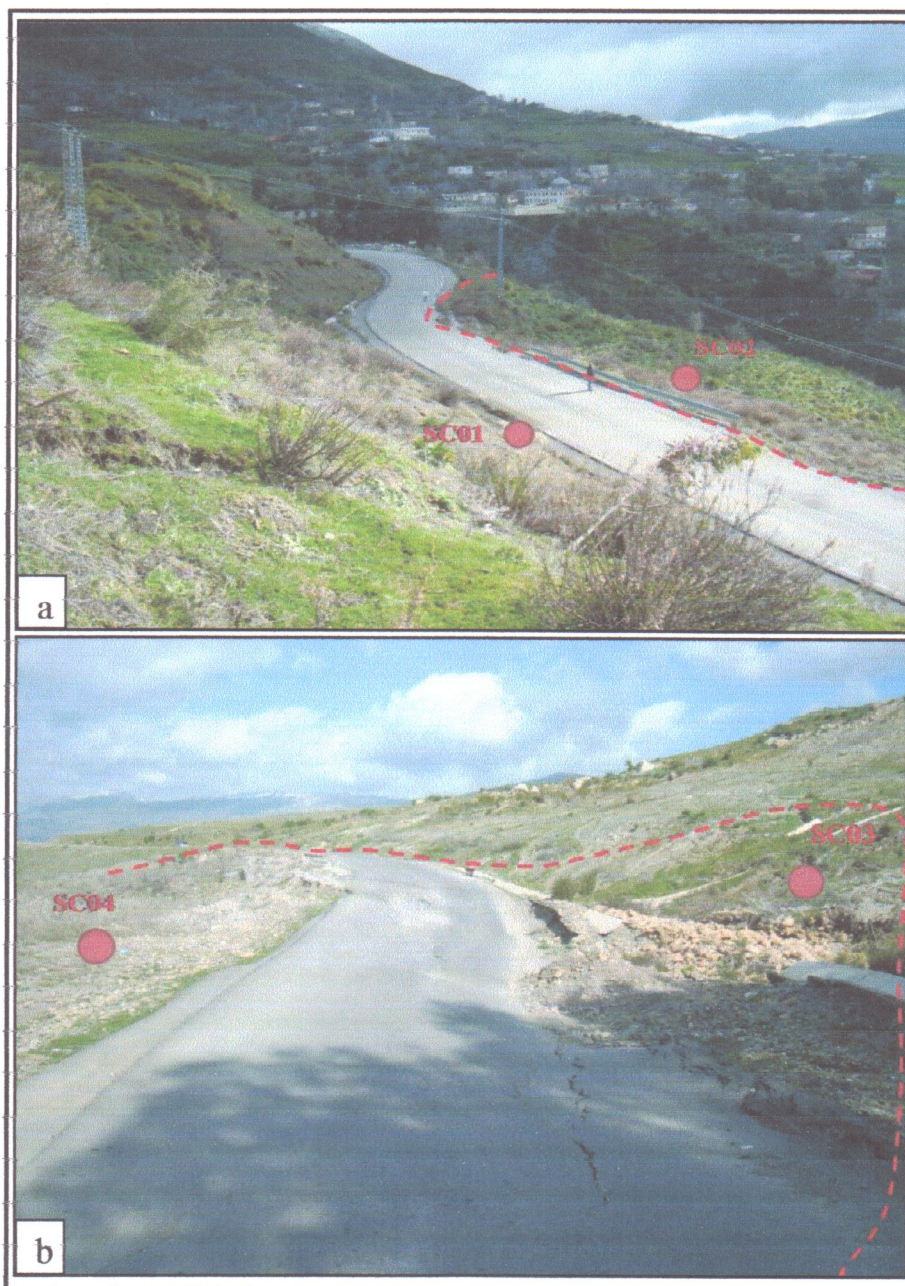
Photo. V.2 - Implantation des sondages carottés a) sondages du 1 er glissement (PK9) ; b) sondages du 2 ème glissement (PK18).
