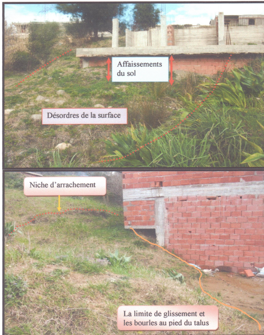
Figure IV.4: Représentation de la masse de glissement au bas de la chaussée
