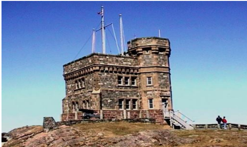
Fig1.3 : Cabot Tower à Terre Neuve [8].
