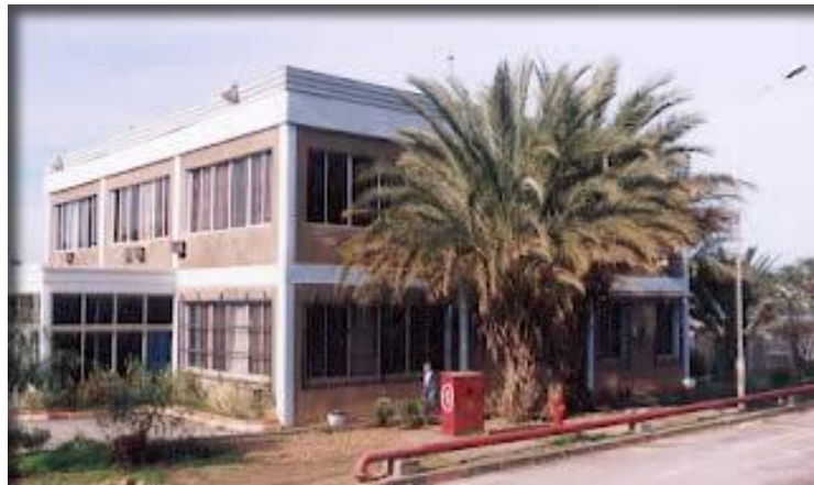
Figure I.1 : Vue de face de l'entreprise.
