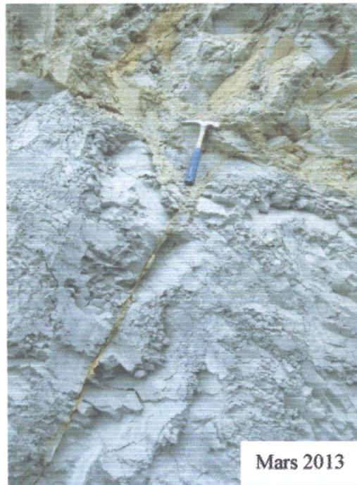
Fig. II.03: Photo illustrant les fractures qui affectent les formations marneuse.
