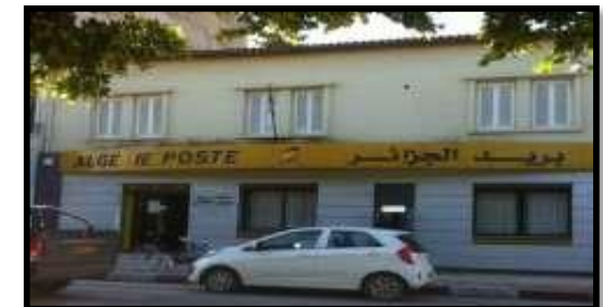
Figure 57: Poste. (Source : Auteurs2019).
