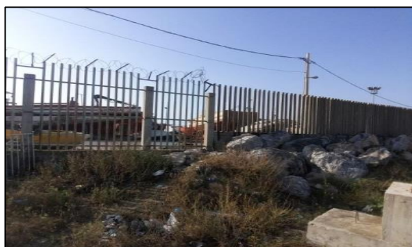
Figure 77 : Clôture installé entre port et front de mer. (Source : Auteurs.2019).
