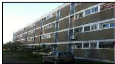
Figure 52 : Cité d'habitats collectifs. (Source : Auteurs2019).
