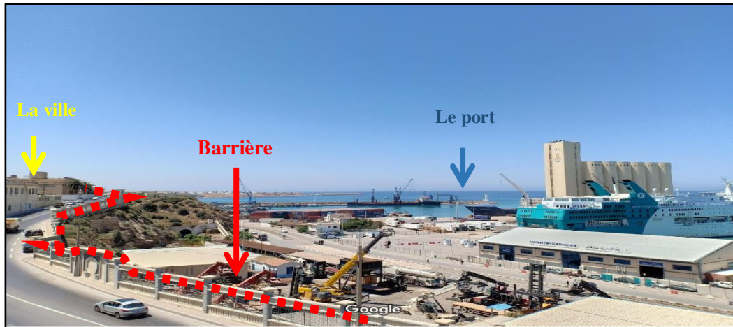
Figure 12 : Les ruptures spatiales du clivage ville/port. (Source : Google Maps).
