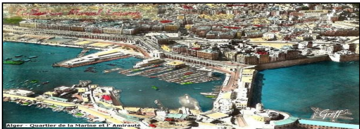
Figure 28: Vue sur le quartier de la marine. (Source : www.pressealgerie.fr ).
