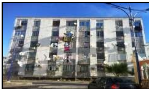
Figure51: Cité d'habitats collectifs. (Source : Auteurs2019).
