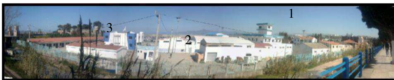
Figure 62: Les installations portuaires qui occultent la vue sur le port, 1 : Direction EGPP, 2 : Hangar, 3 : Centre nautique. (Source : Auteurs. 2019).
