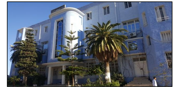
Figure55: L'hôtel Kotama. (Source : Auteurs2019).
