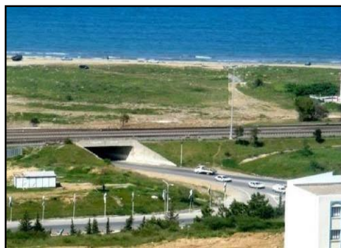
Figure 44 : Accès de l'entré Est (Source : Auteur.2019)
